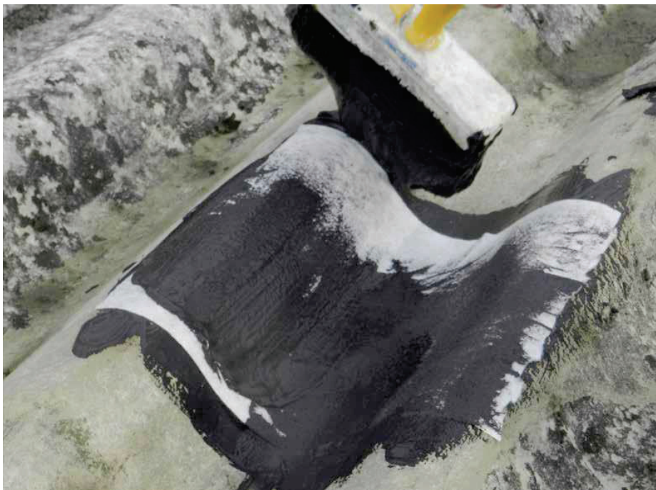
Stesura di due mani di guaina elastomerica
