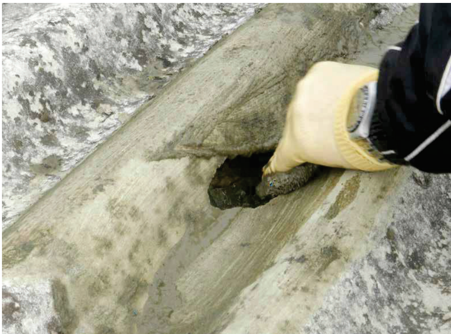
Pulitura della lastra da muffe e parti disgregate
