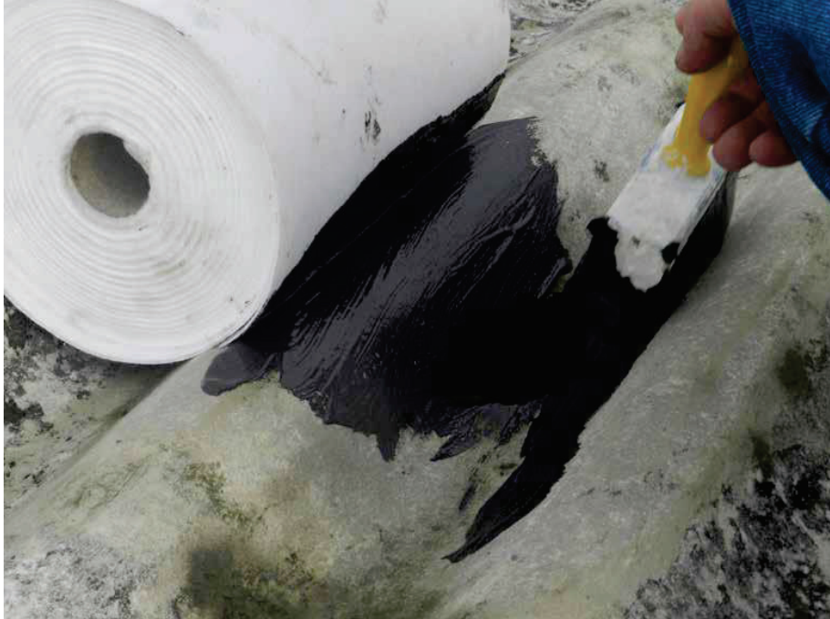
Incollaggio del tessuto non tessuto antifessura in poliestere
