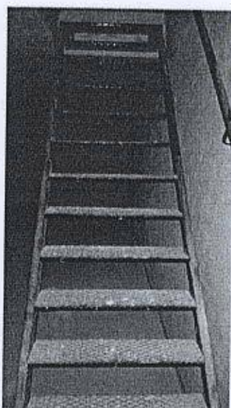
Scala di accesso dal garage alla cantina
