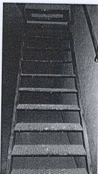
Scala di accesso dal garage alla cantina
