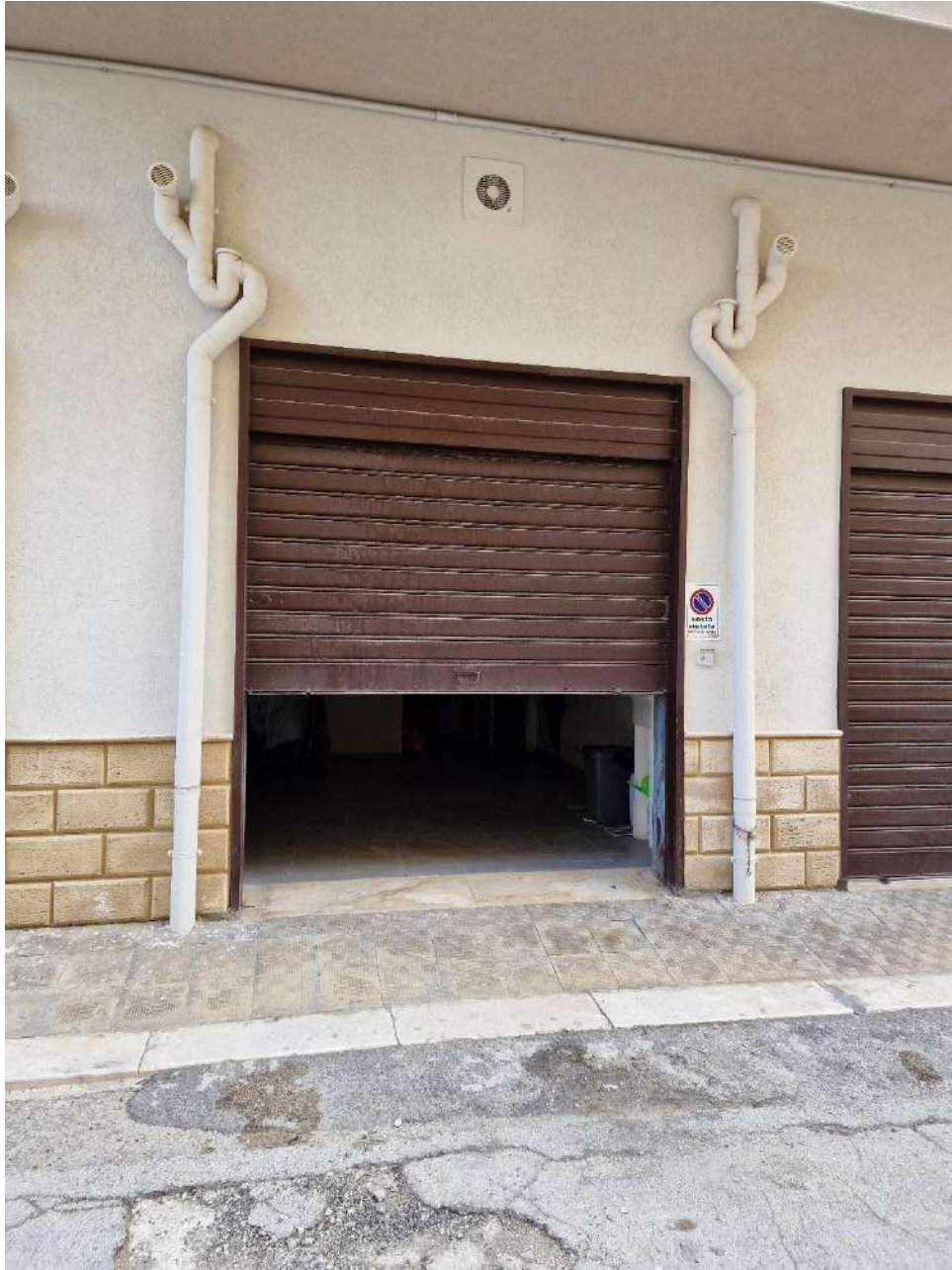
Prospetto sud del Locale terraneo (Lotto 2)
