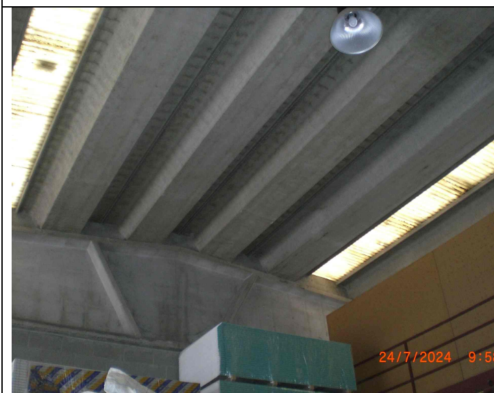
La struttura di copertura in travi precomprese
