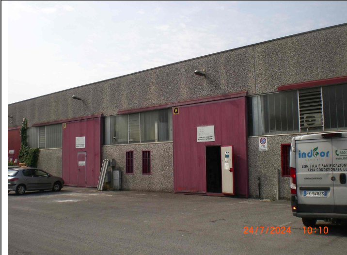
Ingresso dal piazzale di Via Selvagrecia ai due capannoni.
