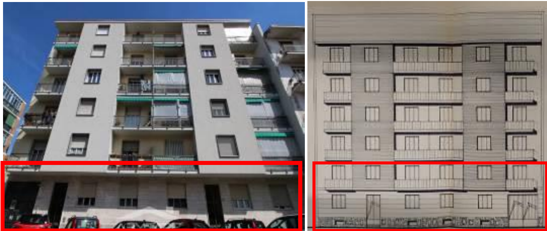
Indicazioni comparative tra lo stato di progetto 1963 e quanto realizzato
