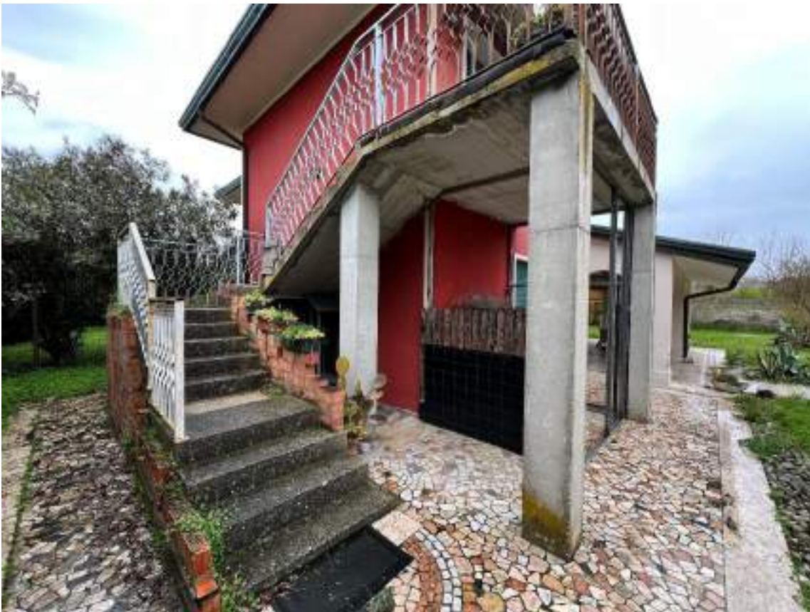
Foto 20 – accesso piano primo
