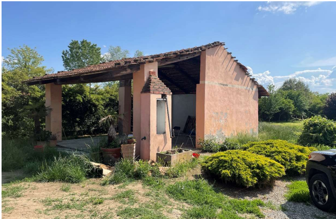
Foto 3 – Vista generale della tettoia isolata
