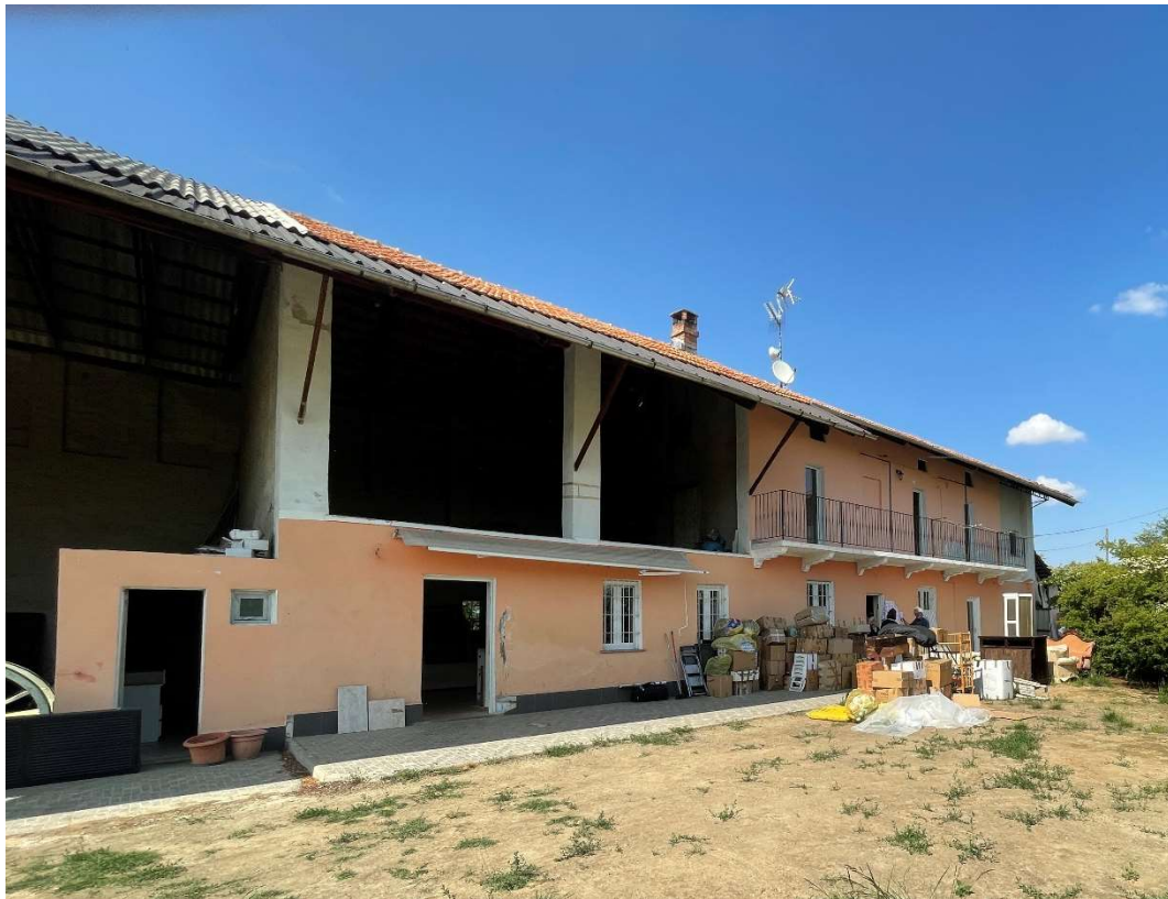
Foto 2 – Vista generale dell'abitazione dal cortile
