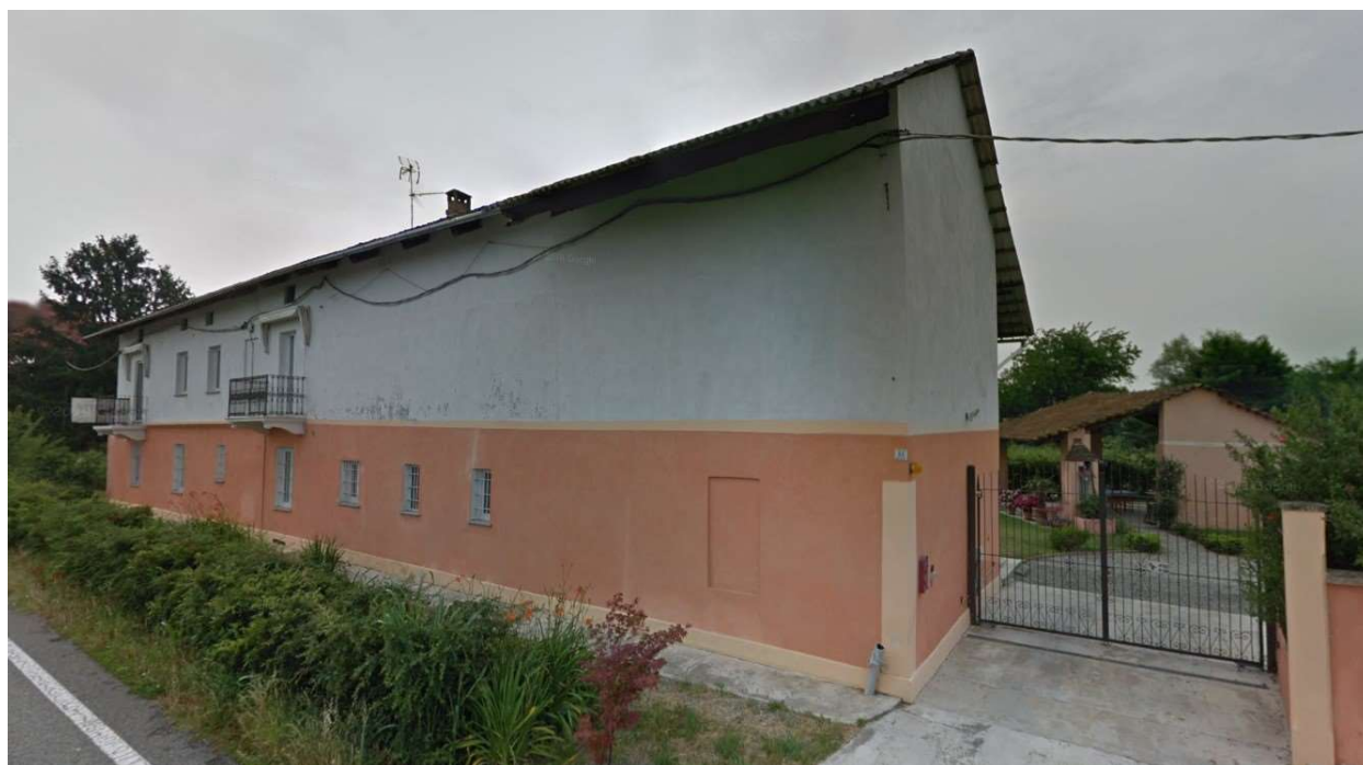
Foto 4 – Vista generale dell'immobile dalla strada
