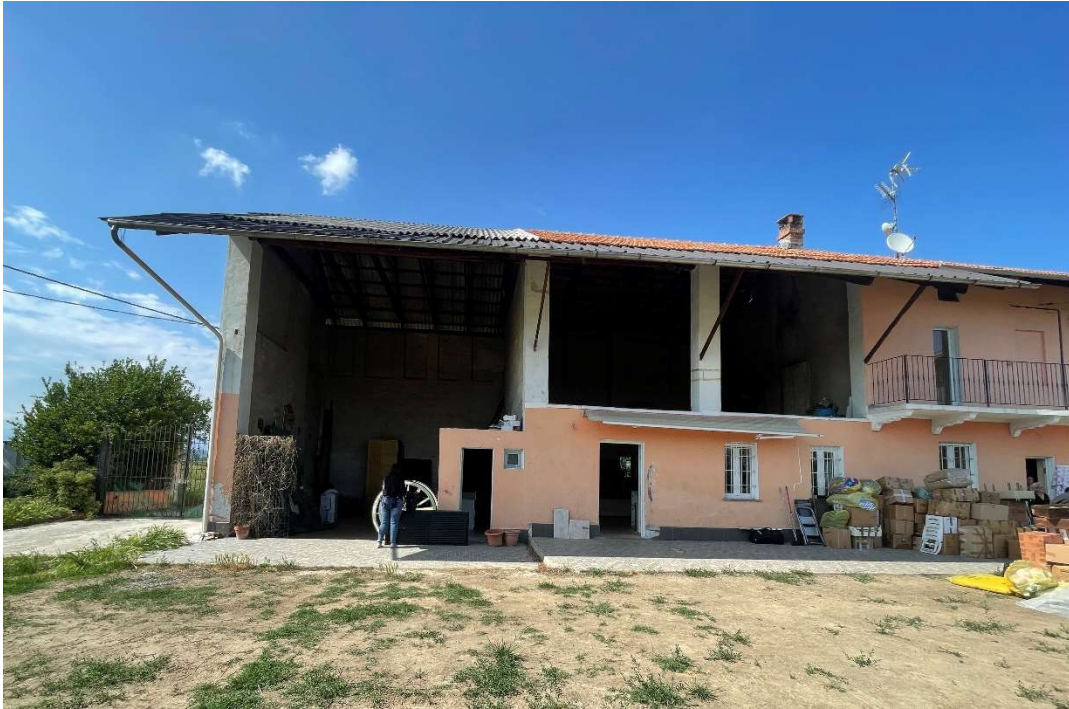
Foto 1 – Vista generale dell'abitazione dal cortile
