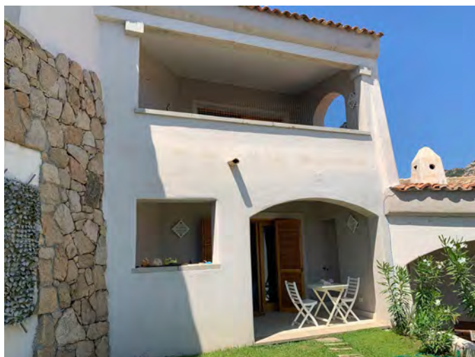
FOTO VERANDA PIANO TERRA
