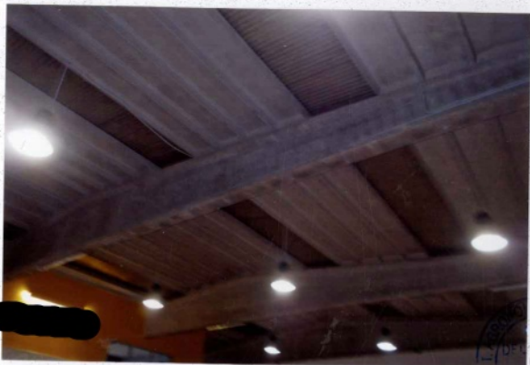
FOTO N. 3 – PARTICOLARE STRUTTURALE DEL CAPANNONE PREFABBRICATO
