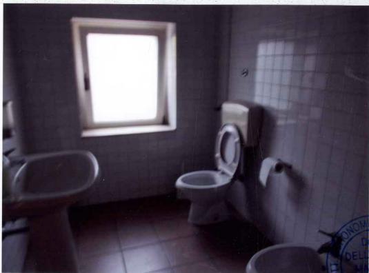
FOTO N.15 – PARTICOLARE BAGNO - SOPPALCO
