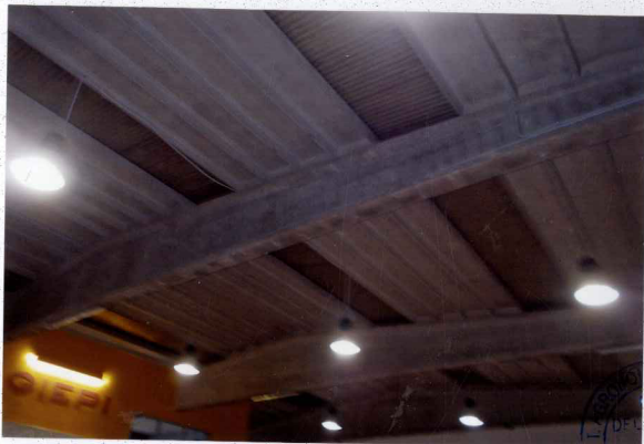
FOTO N. 3 – PARTICOLARE STRUTTURALE DEL CAPANNONE PREFABBRICATO
