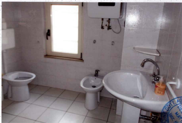
FOTO N. 8 – PARTICOLARE LOCALE BAGNO
