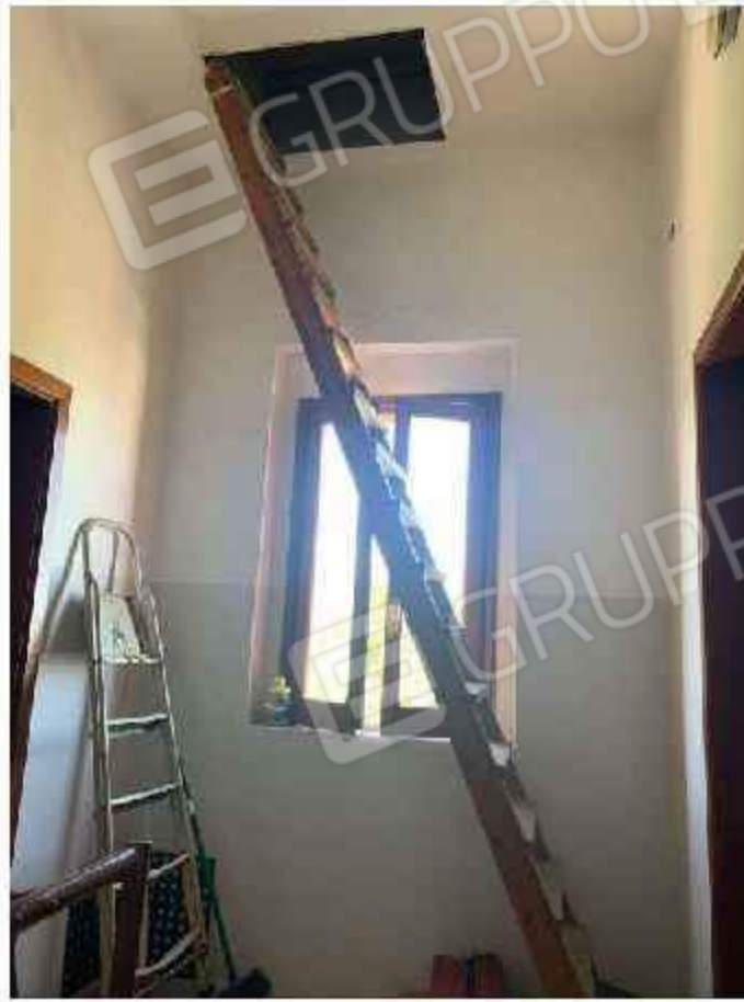
Foto 3-4: Comune di Vico del Gargano (FG) – Località San Menaio Botola di accesso al terrazzo del fabbricato in Via Pineta Marzini n. 42
