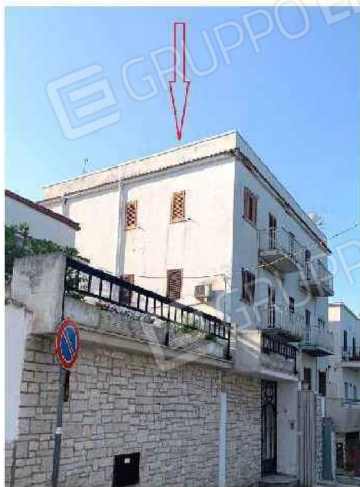
Foto 1-2: Comune di Vico del Gargano (FG) – Località San Menaio Terrazzo del fabbricato in Via Pineta Marzini n. 42
