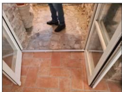
FOTO 109 - LOTTO D Dettaglio pavimento
