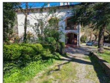
FOTO 9 - LOTTO B e C Viale d'accesso privato
