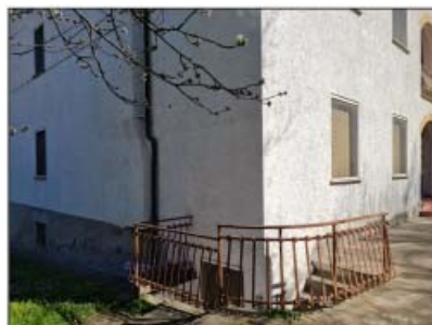
FOTO 17 - LOTTO B e C Ingresso cantina p.seminterrato
