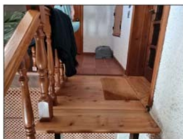
FOTO 23 - LOTTO B e C Ingresso piano sottotetto
