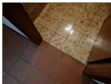
FOTO 54 - LOTTO B Dettaglio pavimenti
