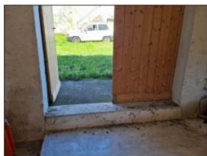
FOTO 82 - LOTTO D Ingresso deposito
