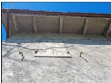
FOTO 88 - LOTTO D Dettaglio copertura e cornicione
