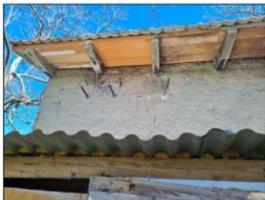
FOTO 79 - LOTTO D Dettaglio copertura
