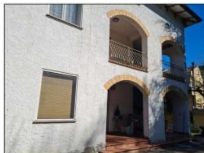
FOTO 15 - LOTTO B e C Dettaglio del fronte principale
