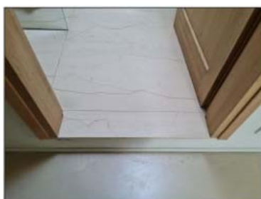
FOTO 35 - LOTTO C Dettaglio pavimento bagno
