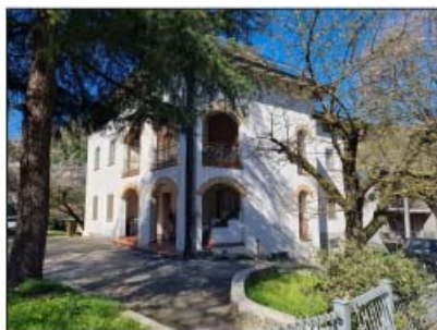
FOTO 4 - LOTTO B e C Vista del fabbricato
