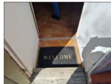
FOTO 90 - LOTTO D Ingresso abitazione
