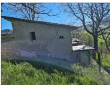
FOTO 74 - LOTTO D Deposito attrezzi con W.C.
