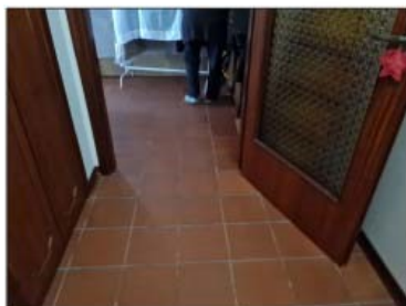
FOTO 47 - LOTTO B Disimpegno
