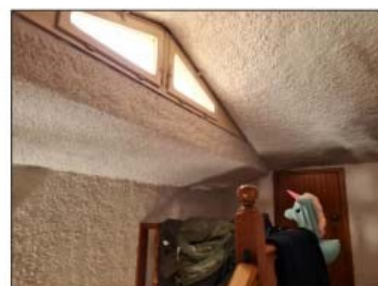
FOTO 24 - LOTTO B e C Ingresso piano sottotetto
