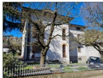
FOTO 6 - LOTTO B e C Prospetto principale
