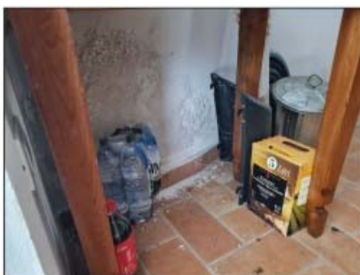
FOTO 96 - LOTTO D Ripostiglio accessibile dall'esterno
