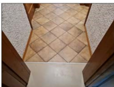
FOTO 34 - LOTTO C Dettaglio pavimenti ingresso
