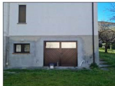
FOTO 18 - LOTTO B e C Portone autorimessa
