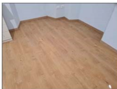
FOTO 116 - LOTTO D Dettaglio pavimento
