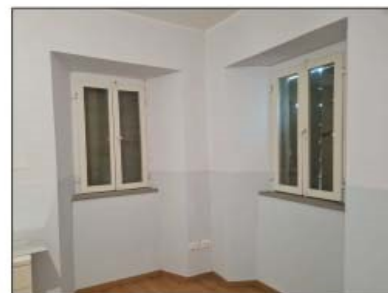
FOTO 108 - LOTTO D Dettaglio muratura e finestre
