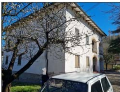
FOTO 5 - LOTTO B e C Vista del fabbricato
