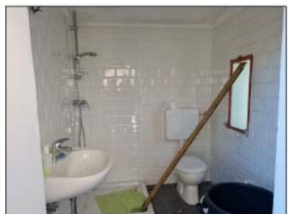
FOTO 94 - LOTTO D W.C. accessibile dall'esterno
