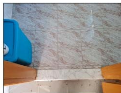
FOTO 117 - LOTTO D Dettaglio pavimento bagno
