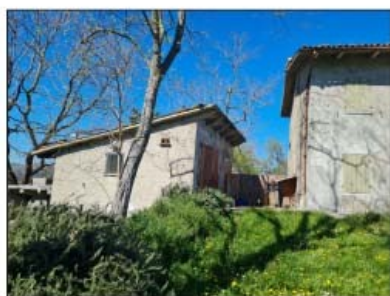
FOTO 73 - LOTTO D Deposito attrezzi con W.C.
