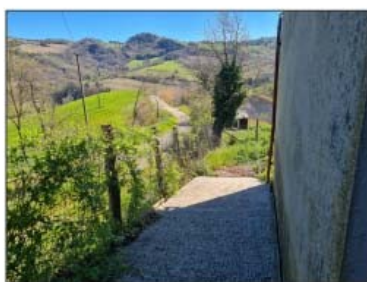
FOTO 92 - LOTTO D Marciapiede e area esterna
