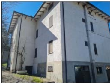
FOTO 10 - LOTTO B e C Vista del retro del fabbricato
