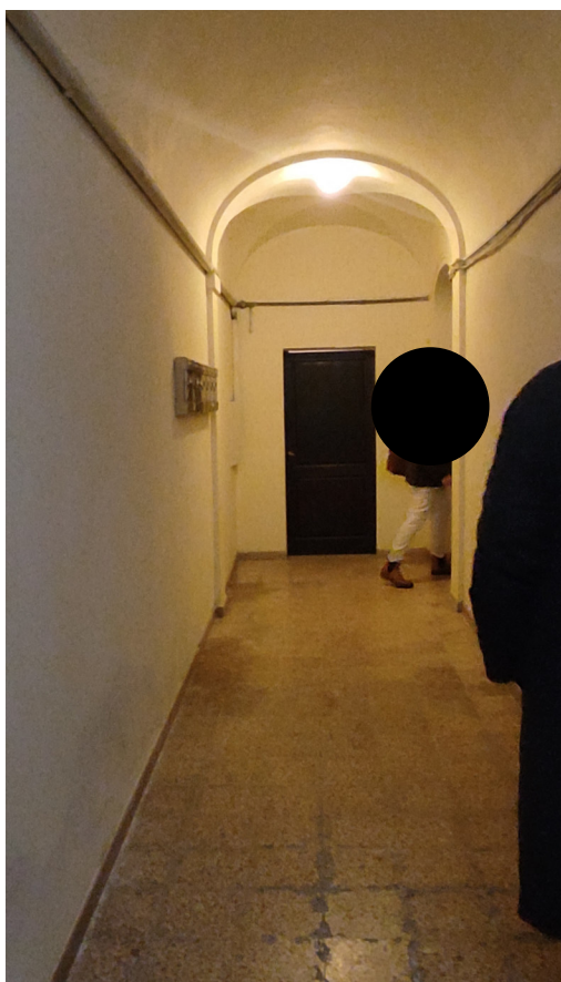
Foto n.2: Particolare del vano scala dell'edificio
