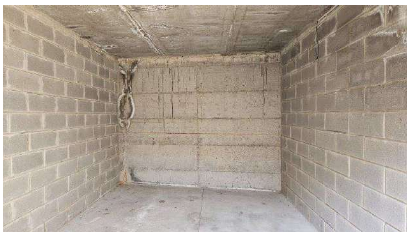
Dettaglio infiltrazioni
