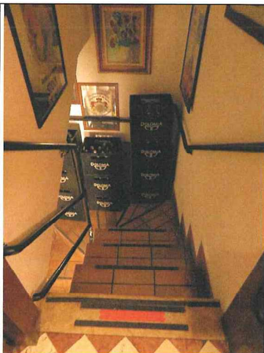
Foto n°86: scale verso interrato
