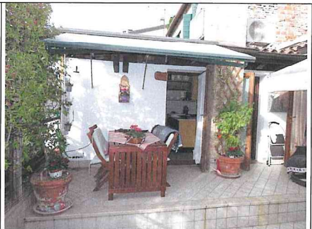
Foto n°17: facciata nord (lavanderia-cucina)
