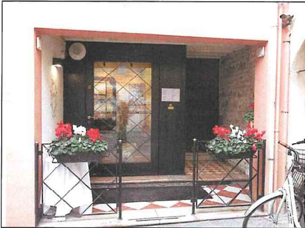
Foto n°6: loggiato di accesso
