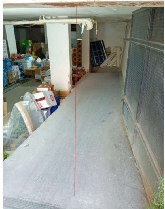
Figura 6 rampa di accesso con altezza minima di 1,75 m
