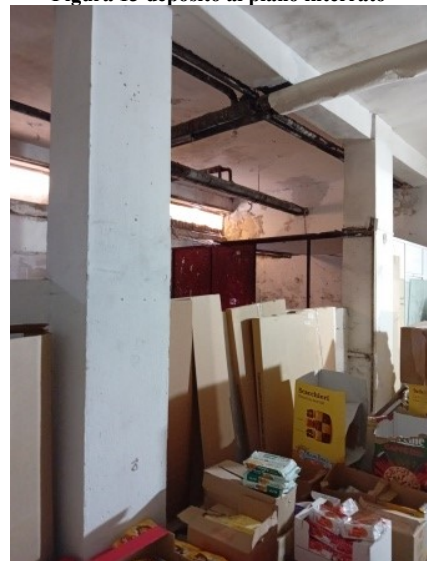
Figura 15 deposito al piano interrato
