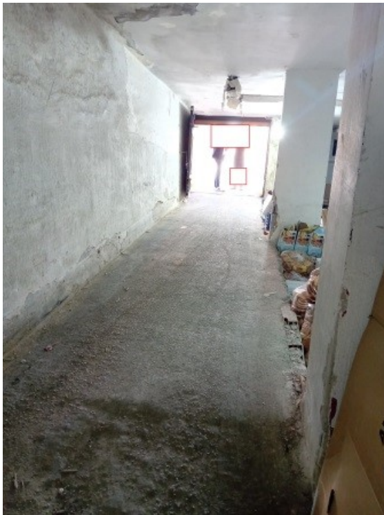
Figura 8 rampa di accesso con altezza minima di 1,75 m
