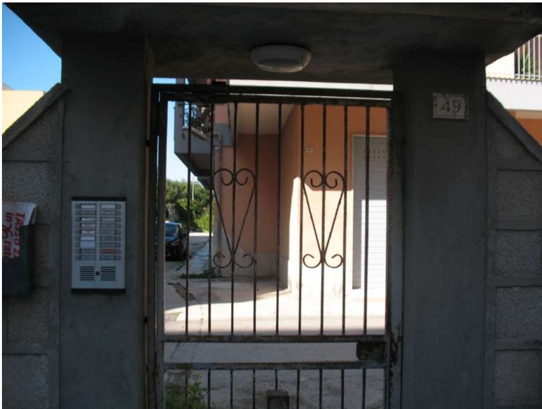
Foto 3 - Cancellone pedonale di accesso al Condominio "Primavera"
