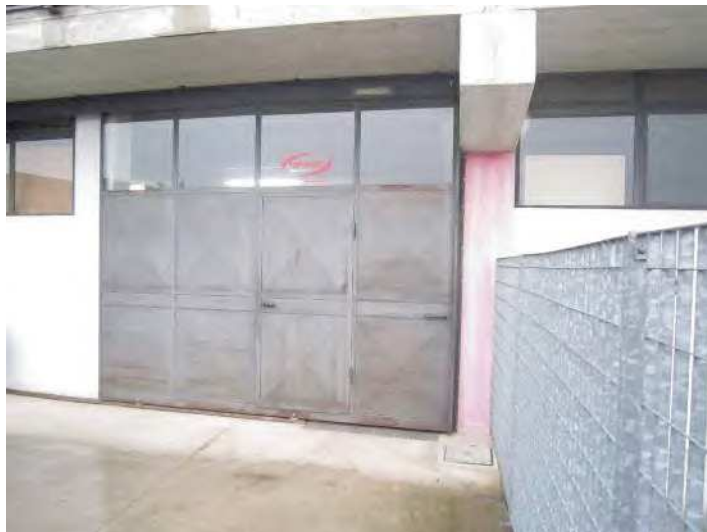
VISTA PORTA DI INGRESSO AL MAGAZZINO/DEPOSITO
