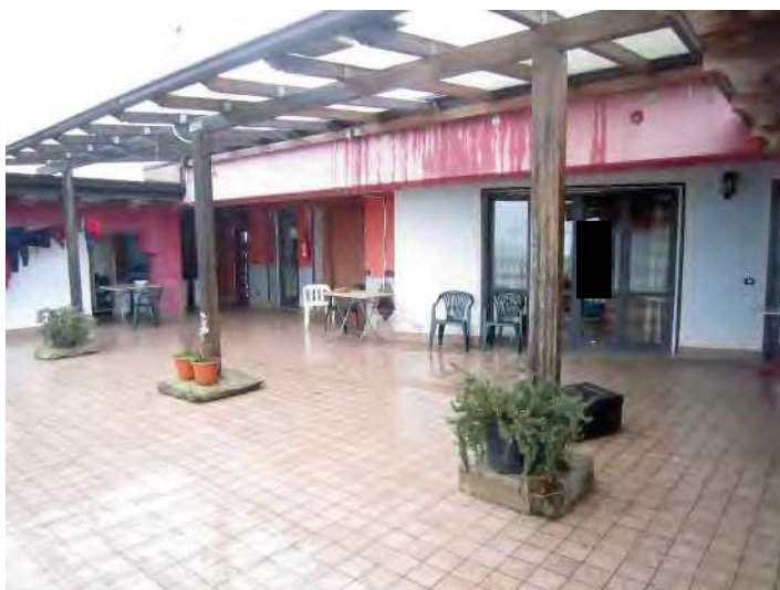
VISTA TERRAZZA COMUNE AL PIANO SECONDO
