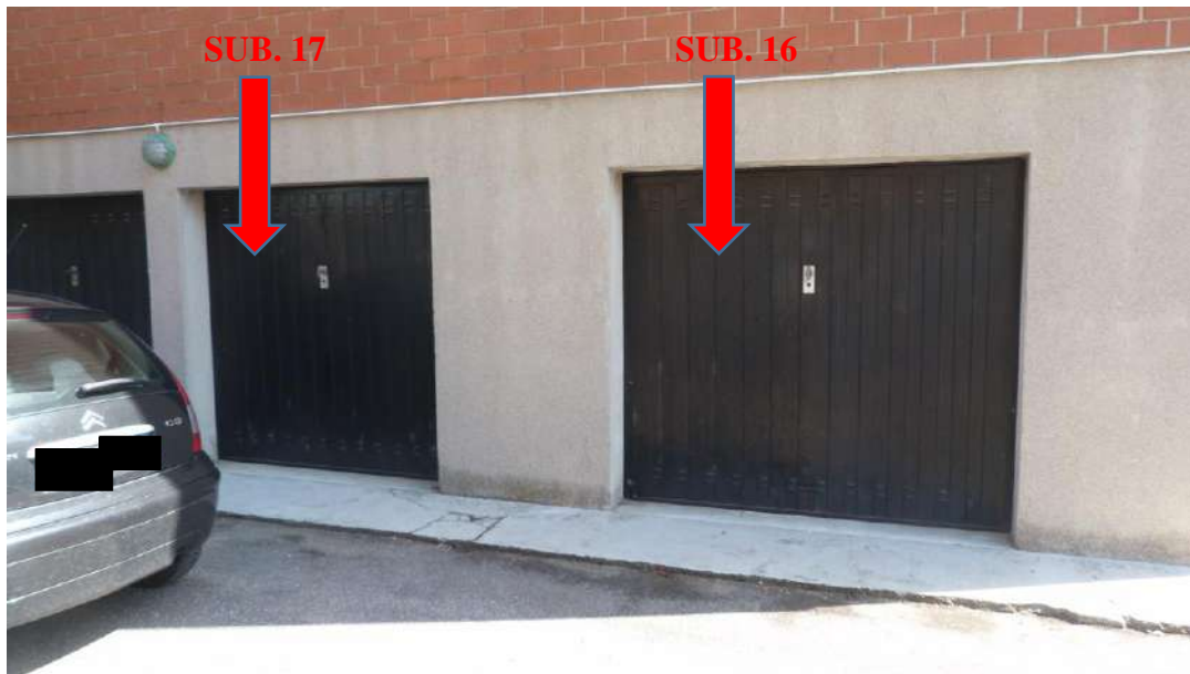
Foto n. 29 – Autorimesse lato Nord
