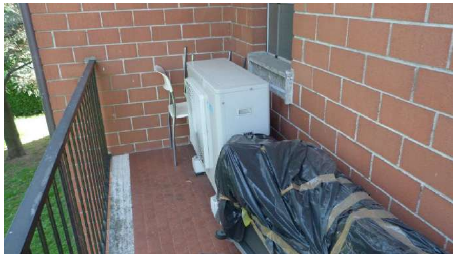
Foto n. 24 – Balcone 1 (lato Est)
