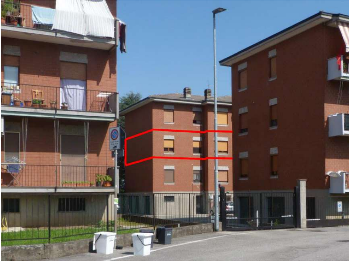
Foto n. 1 – Vista da Via 2° Giugno n. 20 (lato Ovest)
