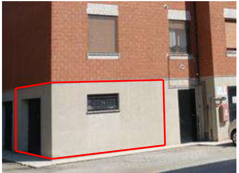
Foto n. 31 – Autorimessa 1 (sub. 16) lato Nord-Ovest
