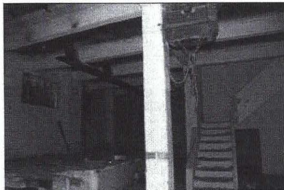
La scala interna risulta in parte priva di parapetto e con gradini parzialmente rotti ed instabili. La pavimentazione dei piani primo e secondo è in legno ed in molte parti pericolante poiché priva di alcune assi, quindi difficilmente accessibile.
