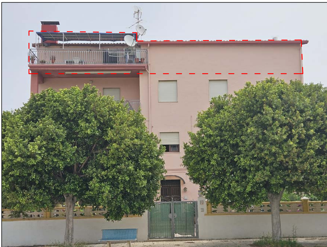
FOTO 03 – Vista generale fabbricato lato Sud-Ovest
