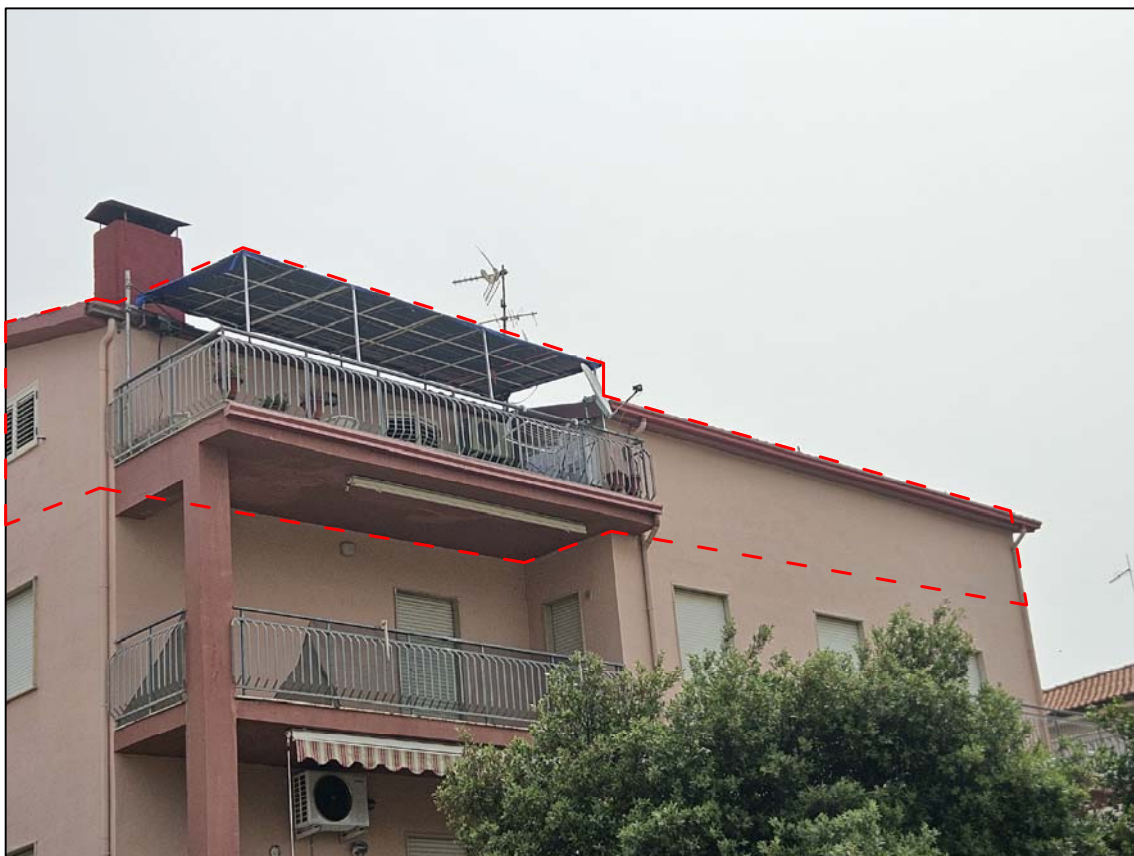
FOTO 07 – Vista esterna appartamento al P.3° lato Sud–Ovest
