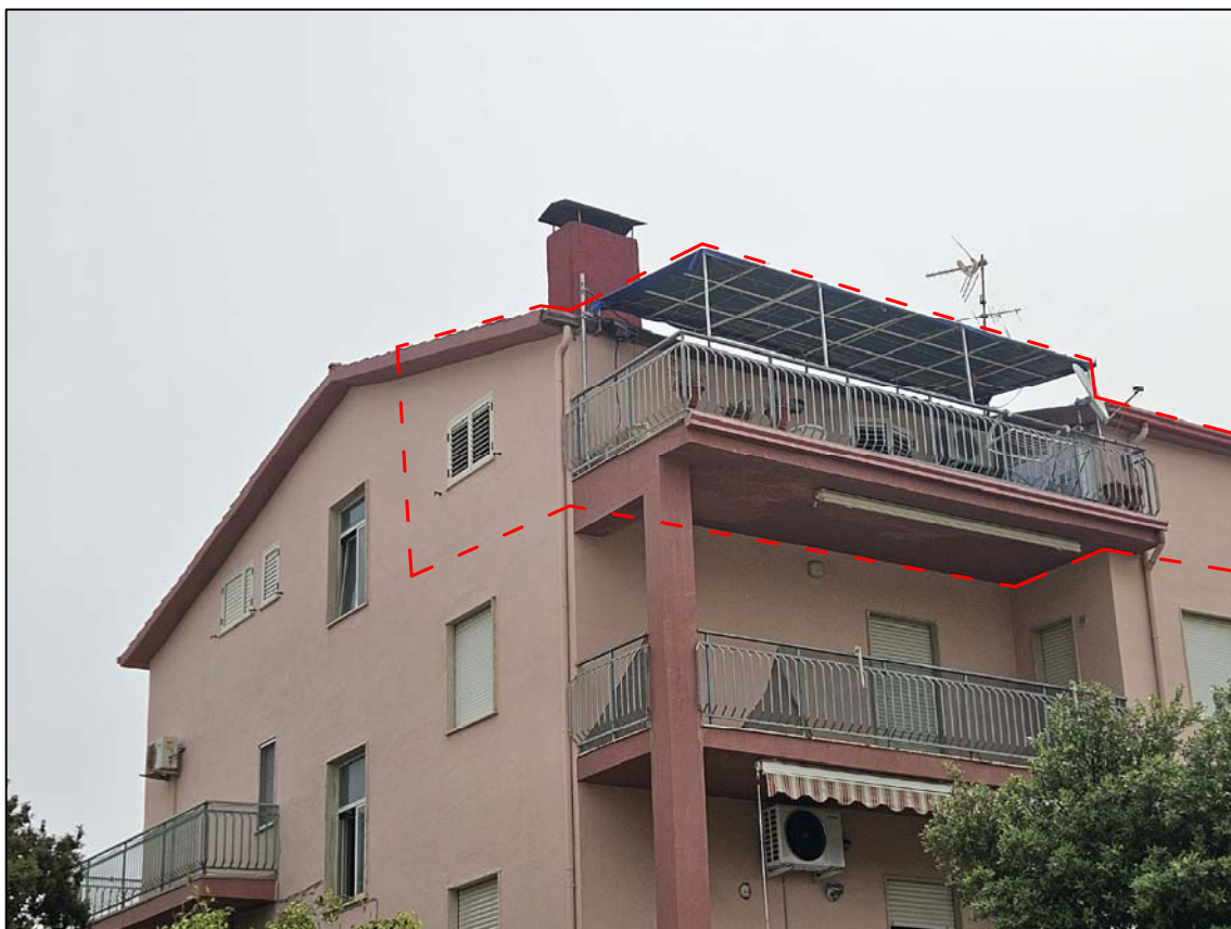
FOTO 06 – Vista esterna appartamento al P.3° lati Nord–Ovest e Sud–Ovest
