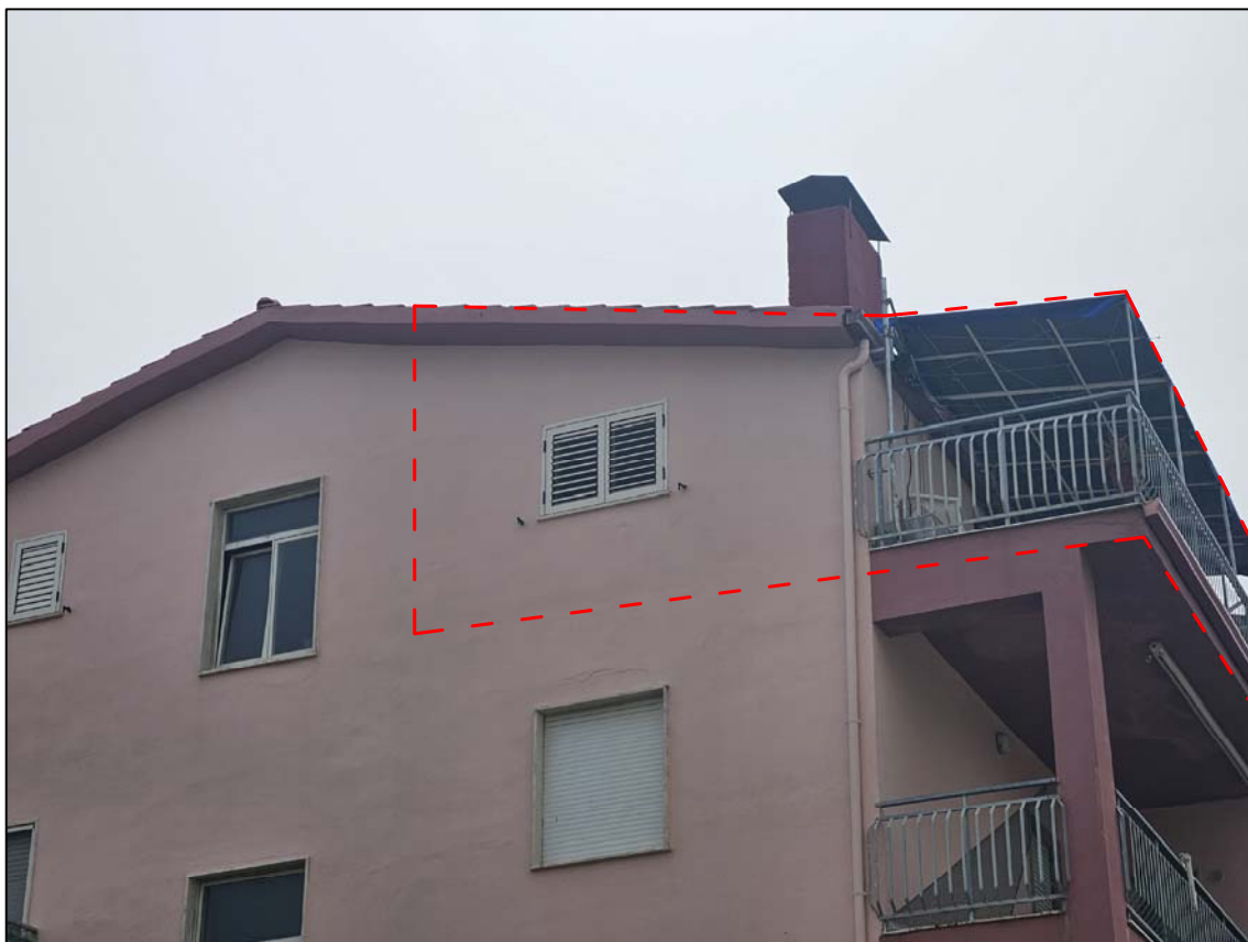
FOTO 05 – Vista esterna appartamento al P.3° lato Nord–Ovest
