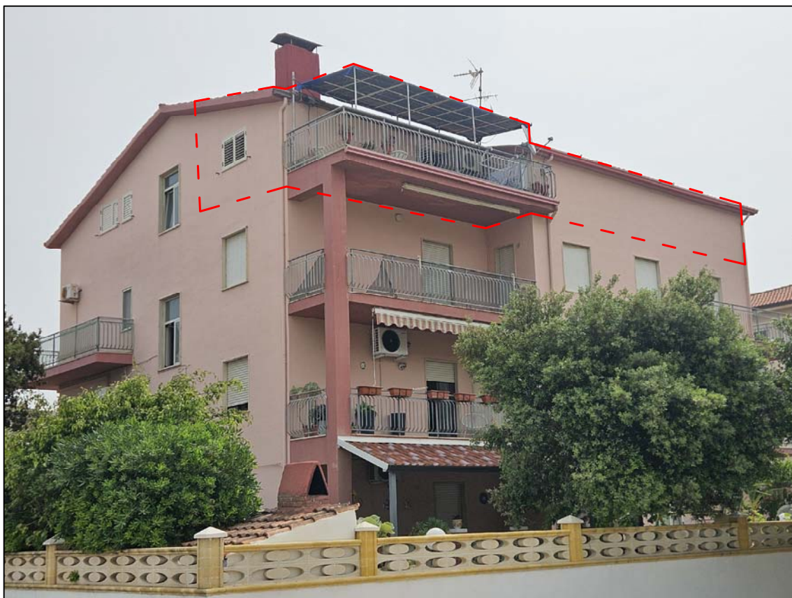
FOTO 02 – Vista generale fabbricato lati Nord–Ovest e Sud–Ovest
