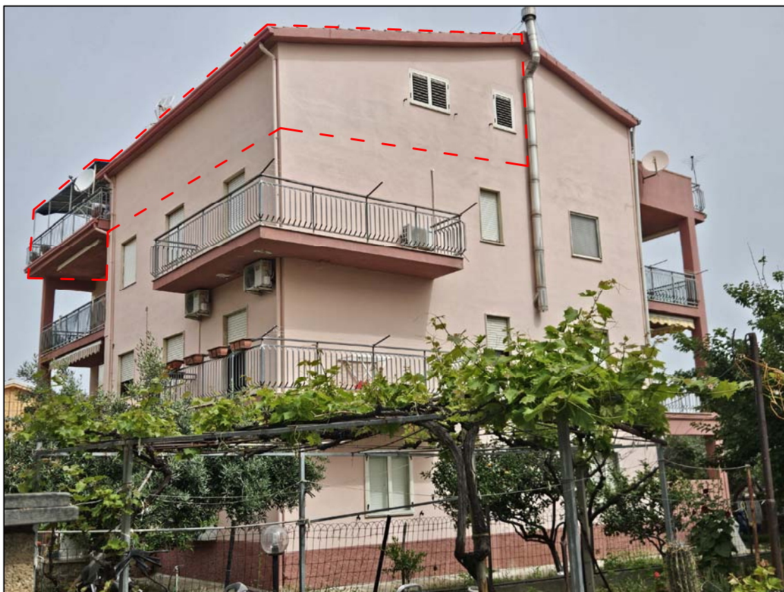
FOTO 04 – Vista generale fabbricato lati Sud-Ovest e Sud-Est
