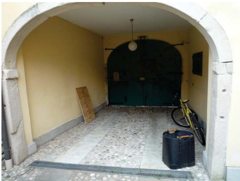
FOTO 05 - Portico Ingresso Comune
