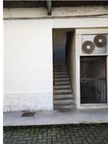
accesso al vano scala
