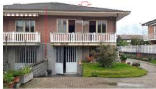
LATO SUD - INTERNO CORTILE
