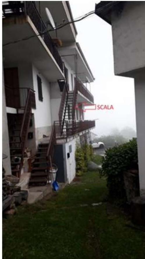
SCALE ACCESSO AL PIANO SECONDO
