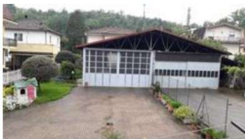
TETTOIA CHIUSA - PORZIONE LATO SINISTRO
