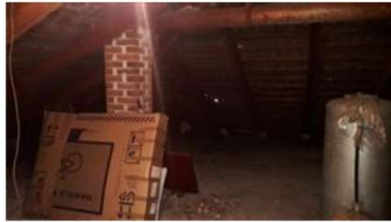
SOTTOTETTO COMUNE A TERZI
