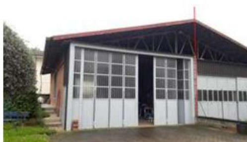
TETTOIA CHIUSA - PORZIONE LATO SINISTRO
