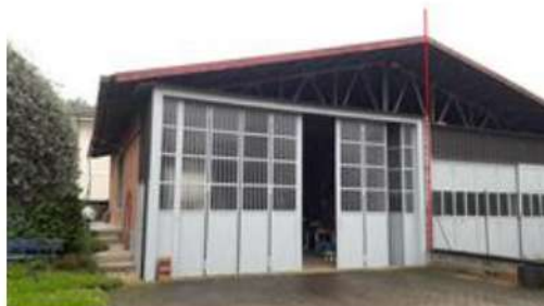
TETTOIA CHIUSA - IN PRIMO PIANO PARTE DIFFORME
