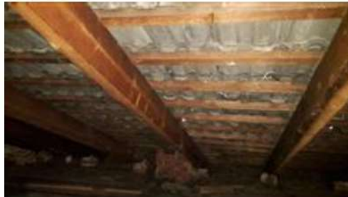
SOTTOTETTO COMUNE A TERZI
