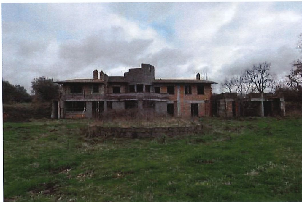
14-Vista esterno fabbricato su p.lla 737
