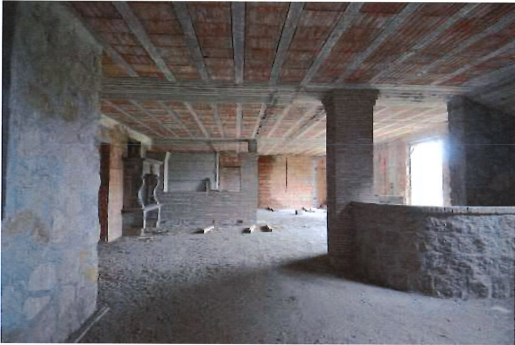
15-Vista interno fabbricato p.lla 737-Piano inferiore
