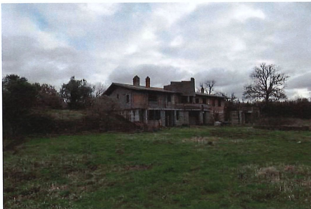
13-Vista esterno fabbricato su p.lla 737
