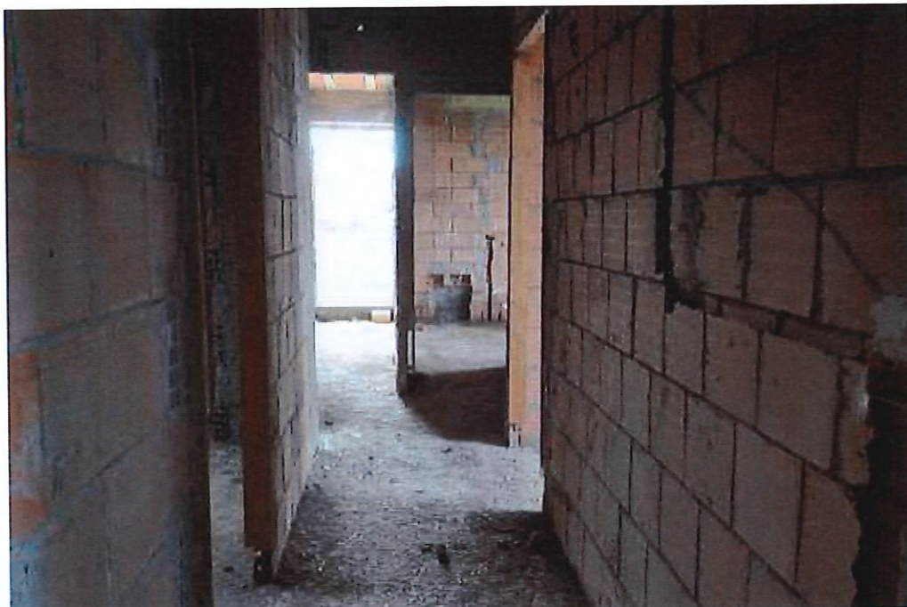
17-Vista interno fabbricato p.lla 737-Piano superiore
