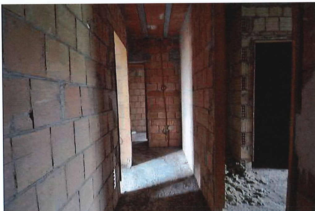
18-Vista interno fabbricato p.lla 737-Piano superiore
