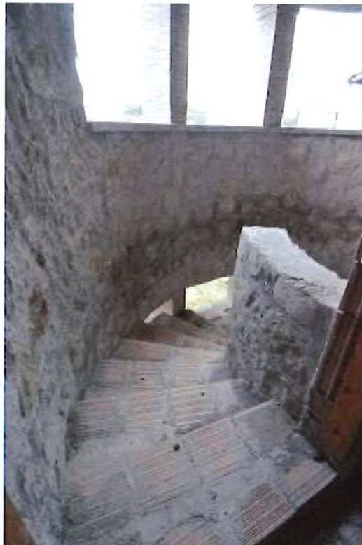
16-Vista interno fabbricato p.lla 737-Scala collegamento tra i due piani
