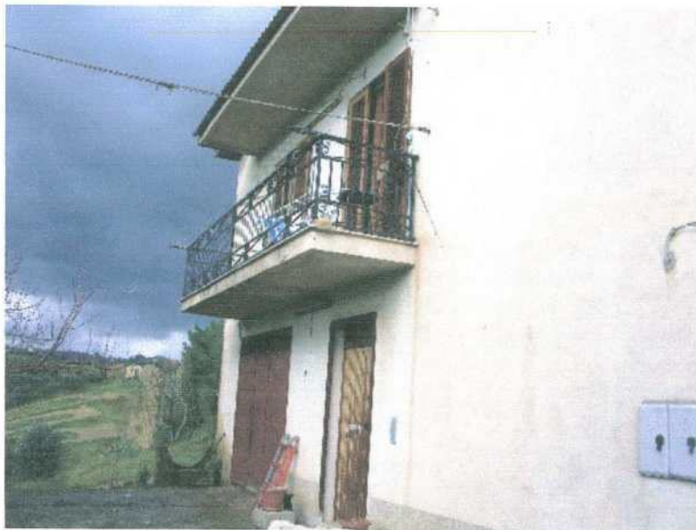
Esterno - lato SUD
