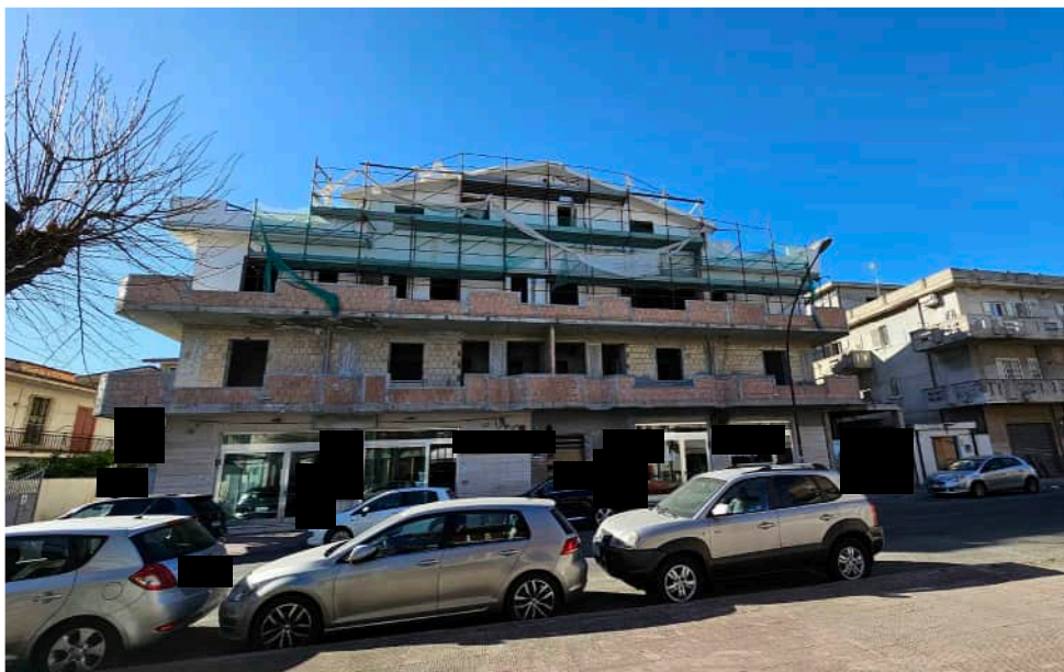
Prospetto su Corso Garibaldi
