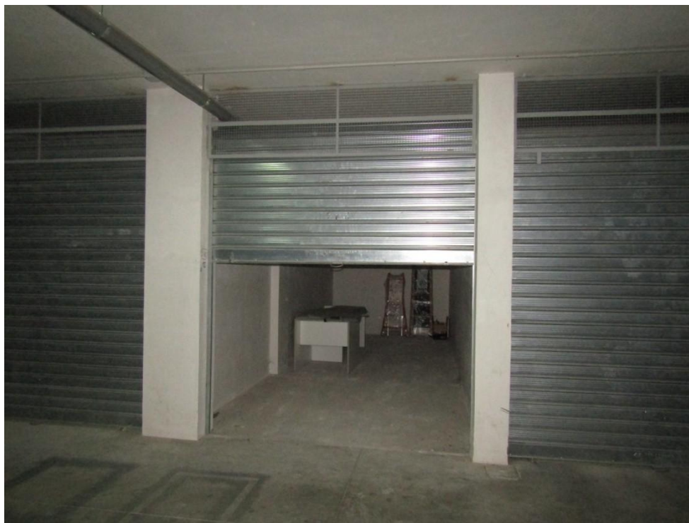
FOTO 30.5 - LOTTO 30 – BOX AUTO IN FOGGIA – PRIMO PIANO INTERRATO – INGRESSO
