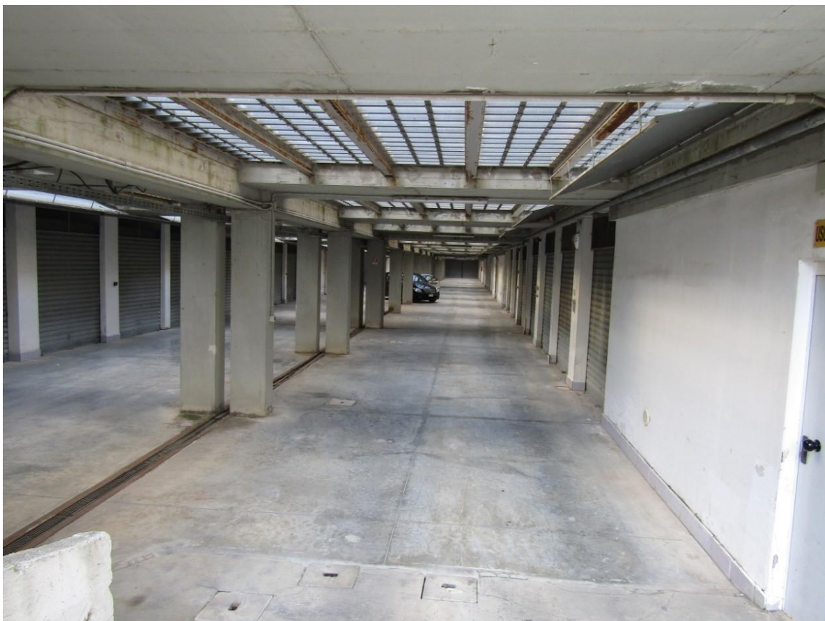
FOTO 30.3 - LOTTO 30 – BOX AUTO IN FOGGIA – PRIMO PIANO INTERRATO
