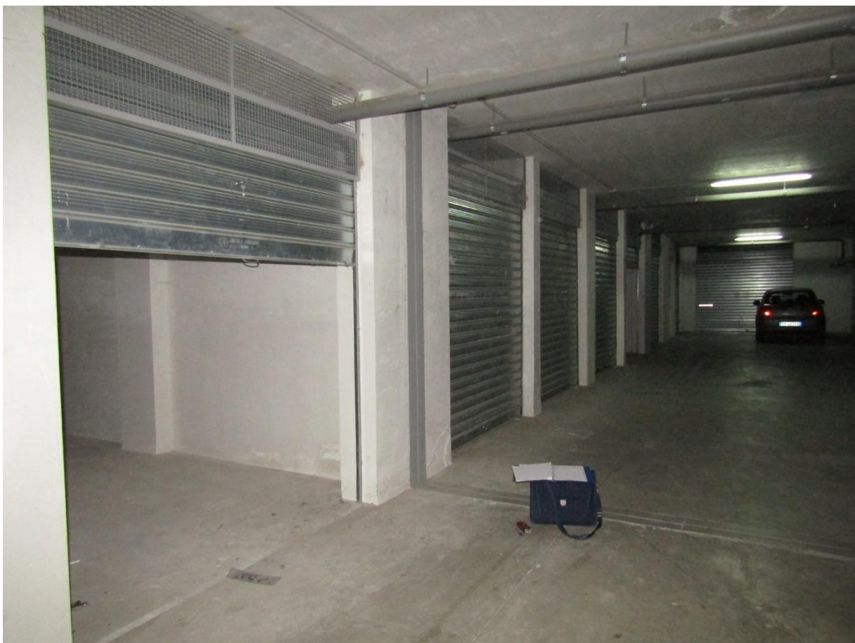
FOTO 28.4 - LOTTO 28 – BOX AUTO IN FOGGIA – PRIMO PIANO INTERRATO – CORSIA DI MANOVRA/INGRESSO
