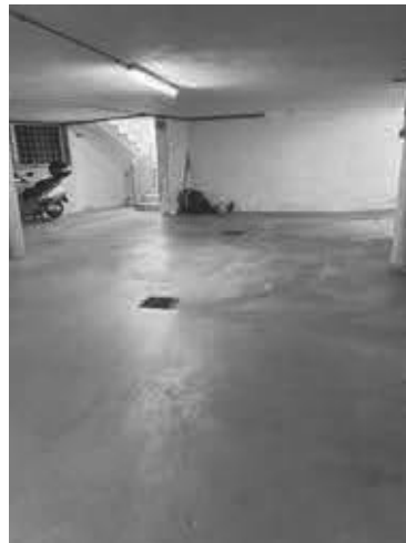
18 Corsia di manovra sub 36
