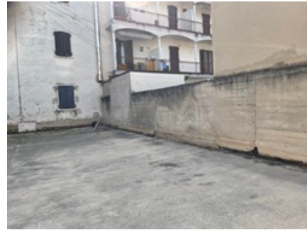
16 Corsia di manovra sub 33
