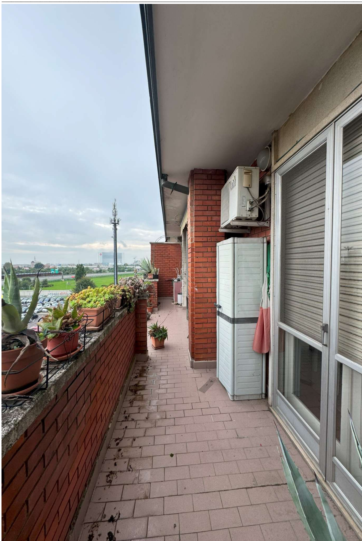
Foto n. 15. Piano Quarto. Balcone 1
