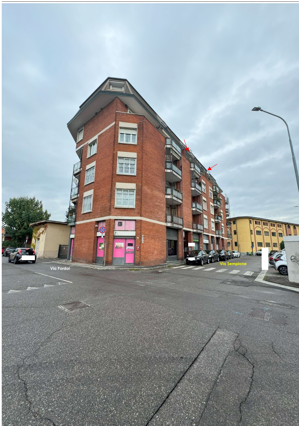
Foto n. 1. Appartamento per civile abitazione al piano quarto con annessa cantina al piano S1 , sito in Baranzate (MI) alla Via Sempione n. 15. Fabbricato condominiale
