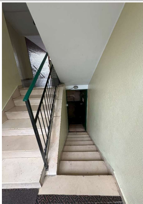
Foto nn. 31-32. Scala di collegamento al piano S1
