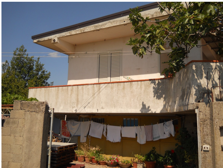
Foto n.1 – Prospetto anteriore dell'immobile
