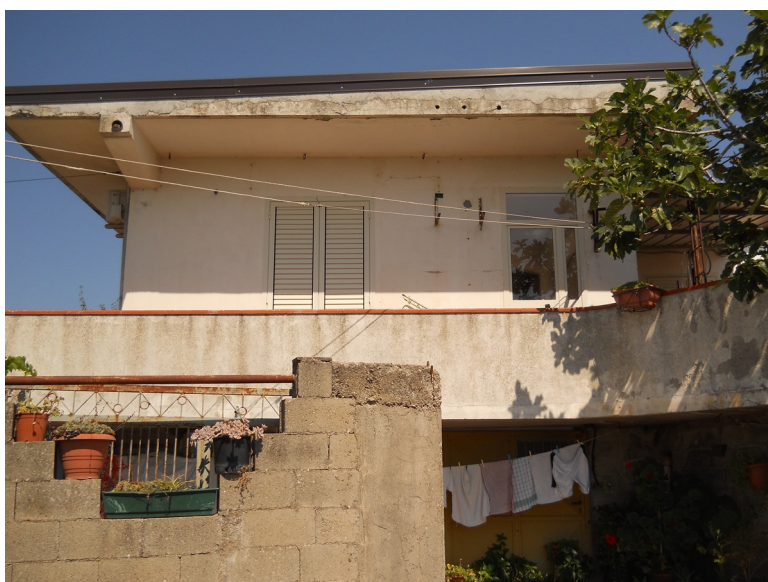
Foto n. 2 – Prospetto anteriore e terrazzo esterno piano terra
