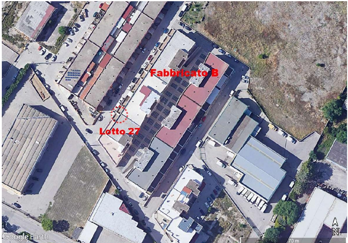
Fig. 1 – LOTTO 27 - Localizzazione dell'immobile all'interno del Fabbricato B sito in Foggia alla via Manfredonia angolo Via delle Casermette - Ortofoto
