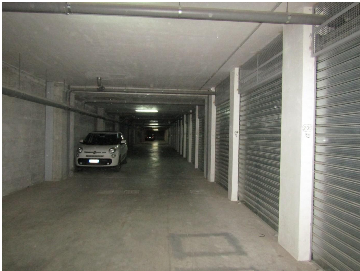
FOTO 27.4 - LOTTO 27 – BOX AUTO IN FOGGIA – PRIMO PIANO INTERRATO – CORSIA DI MANOVRA
