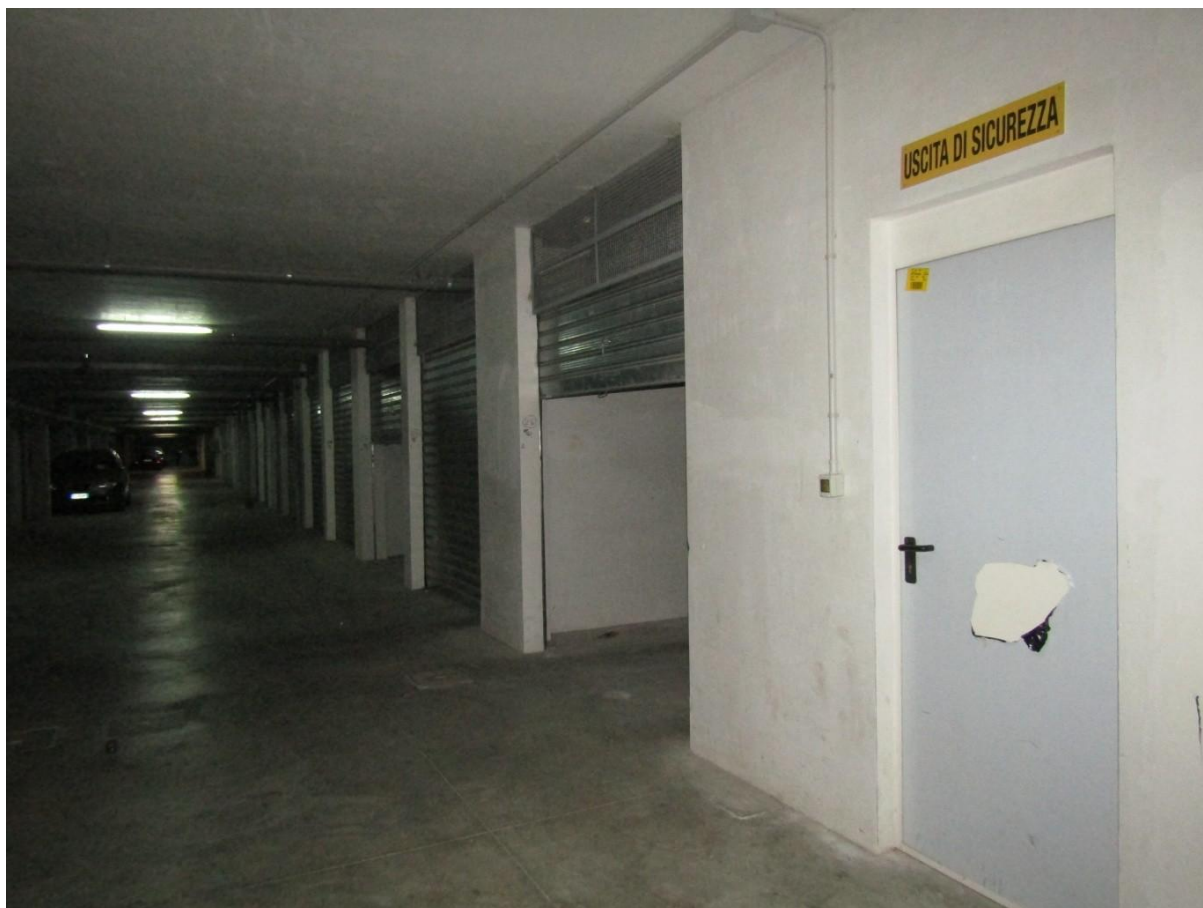
FOTO 32.4 - LOTTO 32 – BOX AUTO IN FOGGIA – PRIMO PIANO INTERRATO – INGRESSO/CORSIA DI MANOVRA
