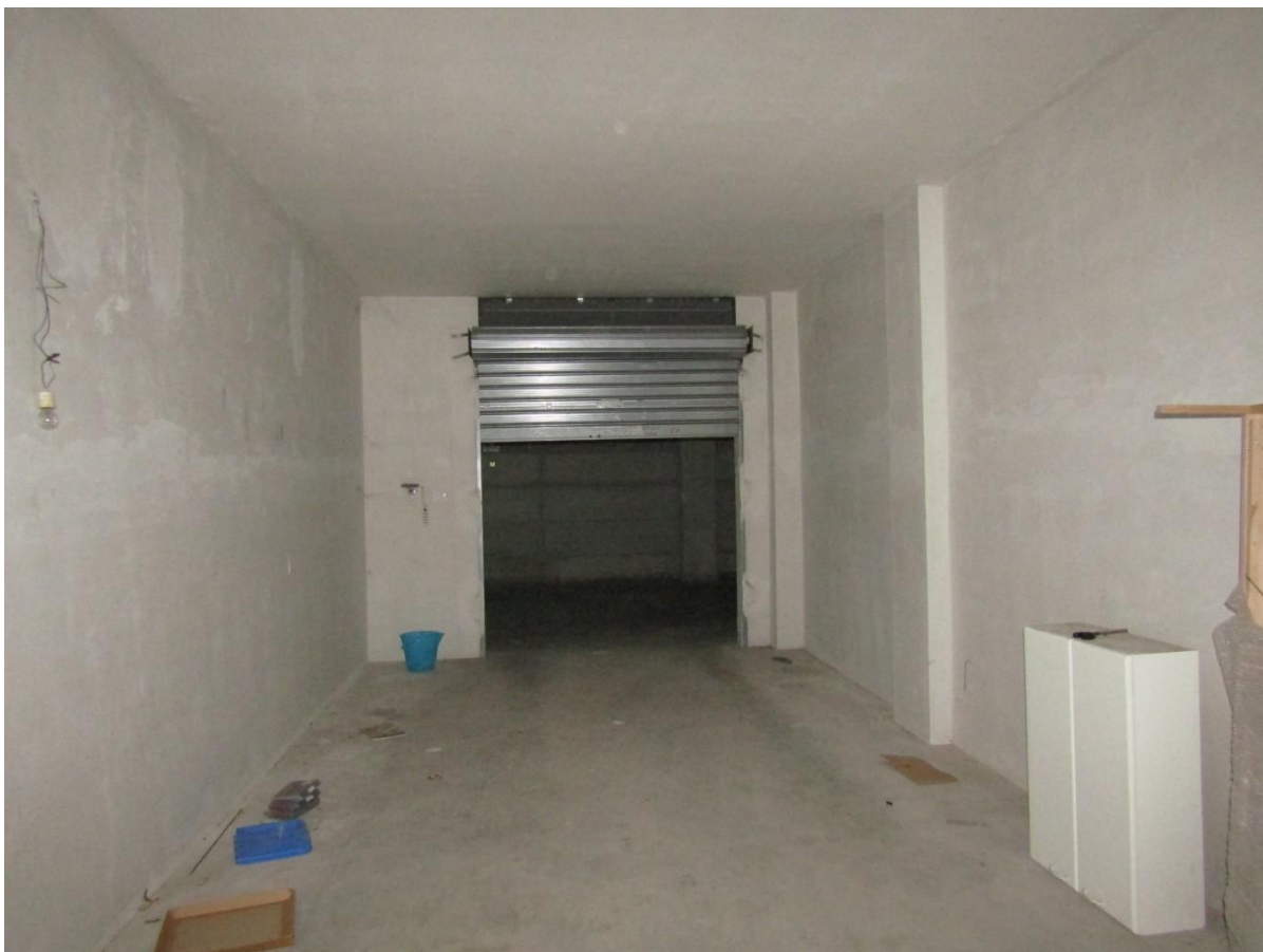
FOTO 32.8 - LOTTO 32 – BOX AUTO IN FOGGIA – PRIMO PIANO INTERRATO – INTERNO
