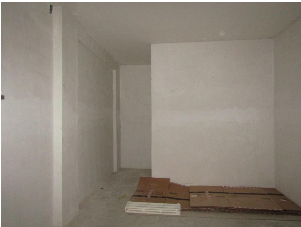
FOTO 32.7 - LOTTO 32 – BOX AUTO IN FOGGIA – PRIMO PIANO INTERRATO – INTERNO
