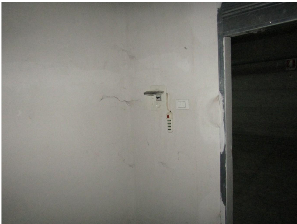
FOTO 32.9 - LOTTO 32 – BOX AUTO IN FOGGIA – PRIMO PIANO INTERRATO – INTERNO
