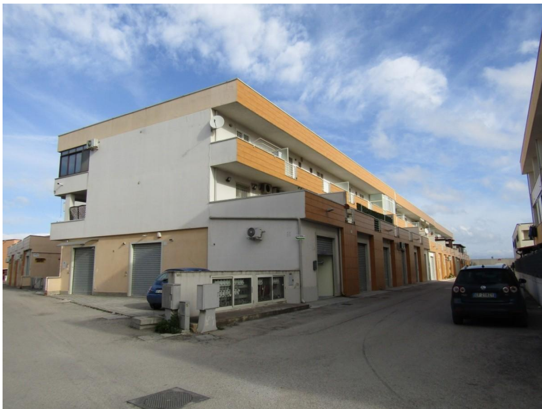
FOTO 25.1 - LOTTO 25 – BOX AUTO IN FOGGIA – FABBRICATO B
