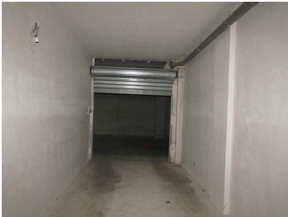
FOTO 25.7 - LOTTO 25 – BOX AUTO IN FOGGIA – PRIMO PIANO INTERRATO – INTERNO
