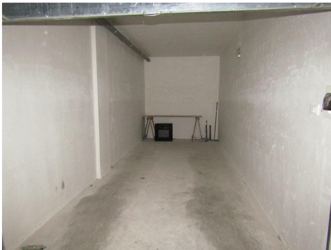
FOTO 25.6 - LOTTO 25 – BOX AUTO IN FOGGIA – PRIMO PIANO INTERRATO – INTERNO
