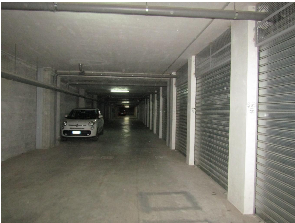
FOTO 25.4 - LOTTO 25 – BOX AUTO IN FOGGIA – PRIMO PIANO INTERRATO – CORSIA DI MANOVRA
