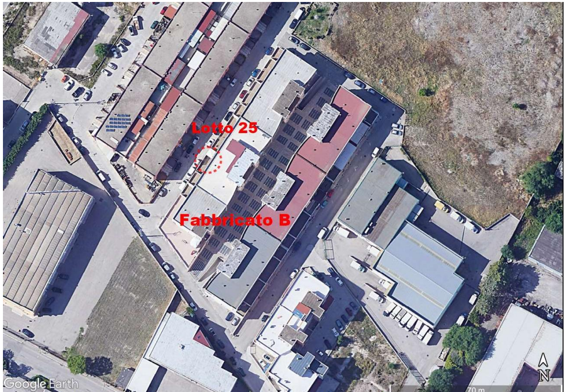
Fig. 1 – LOTTO 25 - Localizzazione dell'immobile all'interno del Fabbricato B sito in Foggia alla via Manfredonia angolo Via delle Casermette - Ortofoto
