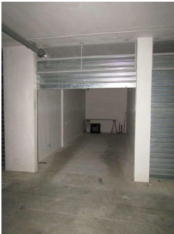
FOTO 25.5 - LOTTO 25 – BOX AUTO IN FOGGIA – PRIMO PIANO INTERRATO – INGRESSO
