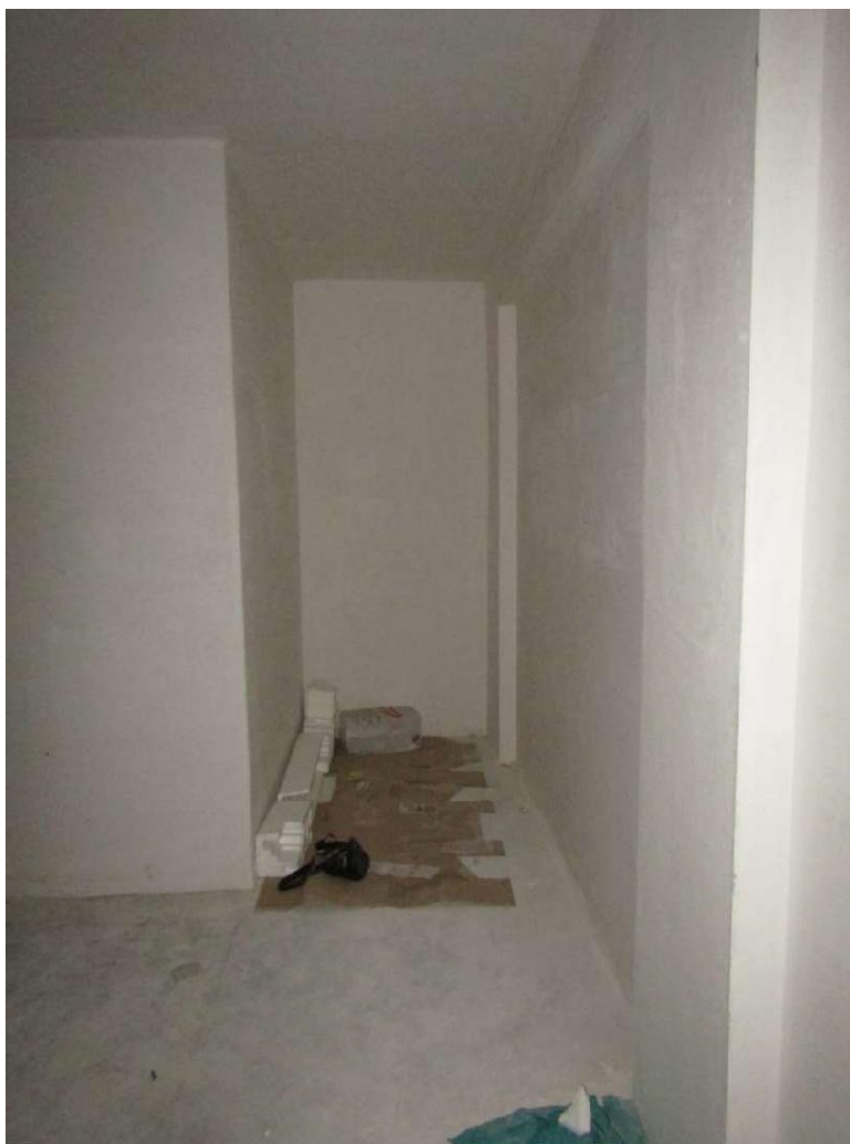
FOTO 22.9 - LOTTO 22 – BOX AUTO IN FOGGIA – PRIMO PIANO INTERRATO – INTERNO
