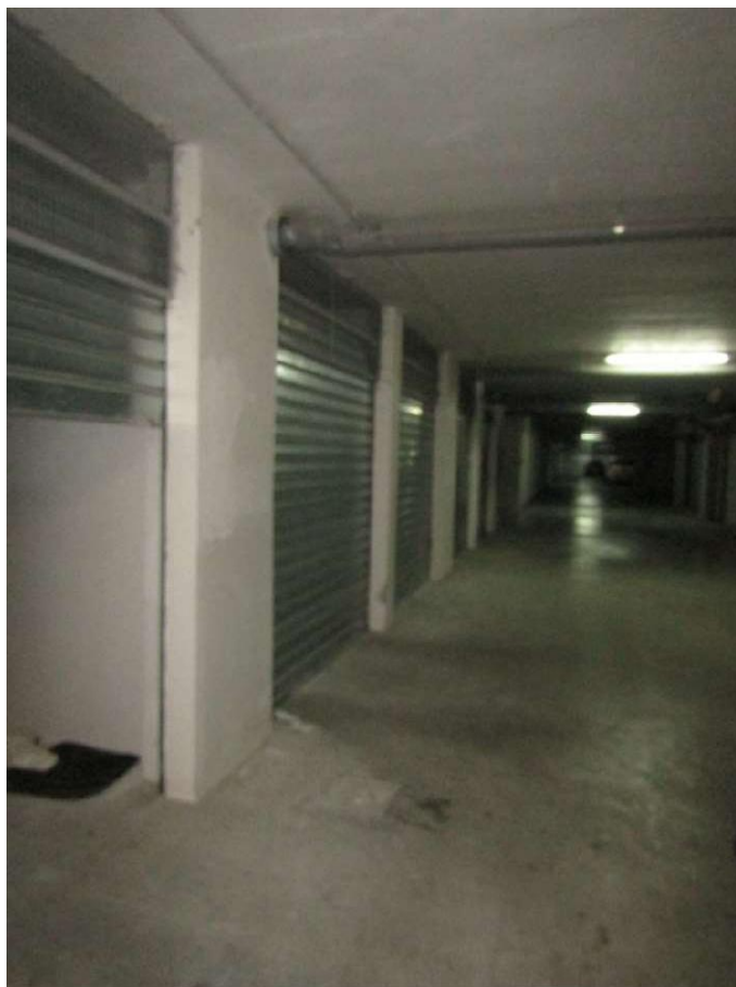
FOTO 22.5 - LOTTO 22 – BOX AUTO IN FOGGIA – PRIMO PIANO INTERRATO – INGRESSO/CORSIA DI MANOVRA
