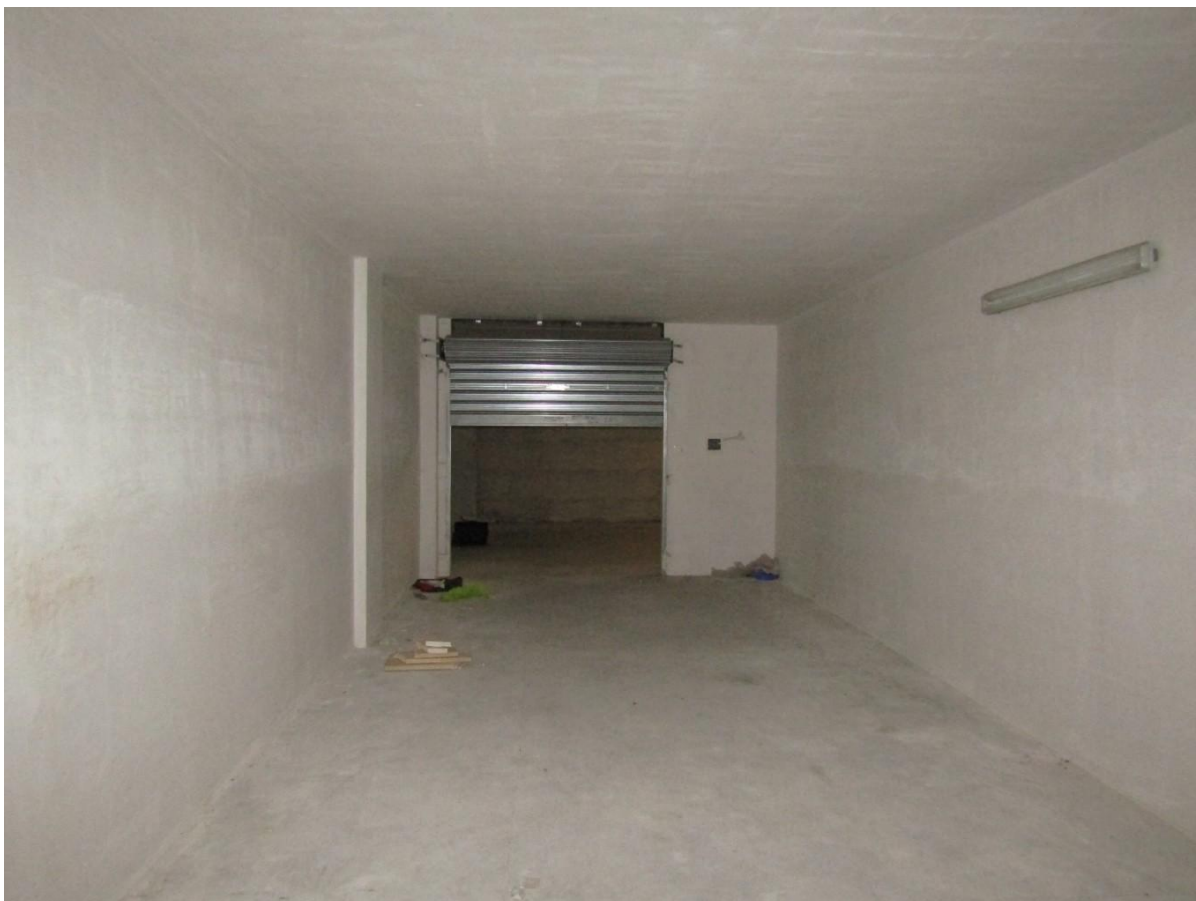
FOTO 22.8 - LOTTO 22 – BOX AUTO IN FOGGIA – PRIMO PIANO INTERRATO – INTERNO
