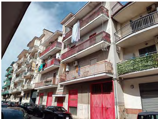
Il fabbricato visto da Via Libertà
