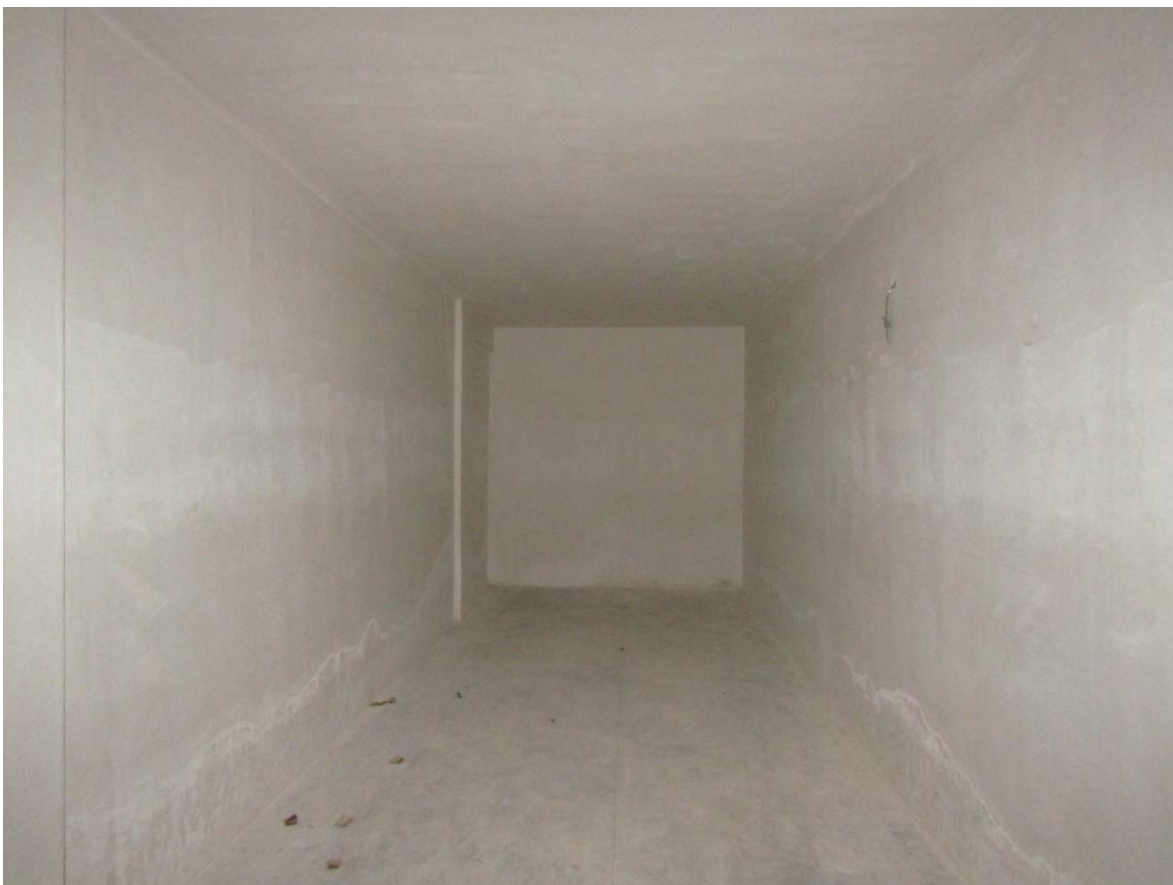
FOTO 20.5 - LOTTO 20 – BOX AUTO IN FOGGIA – PRIMO PIANO INTERRATO – INTERNO
