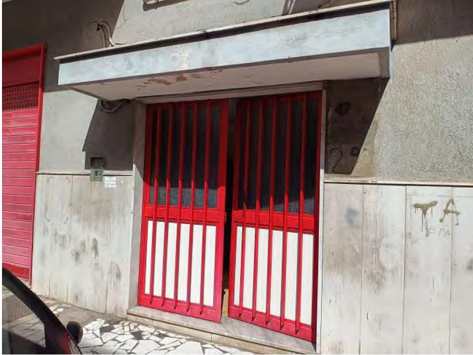
FOTO N. 17 – Porta di ingresso della cassa scala del fabbricato
