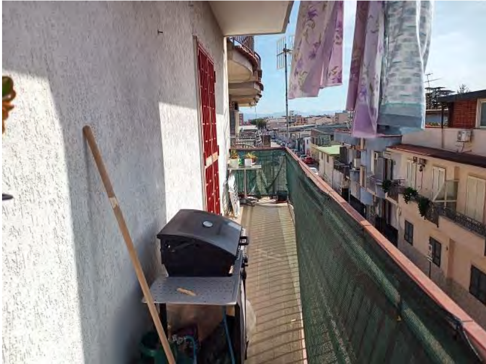
FOTO N. 23 – Balcone lato Sud
