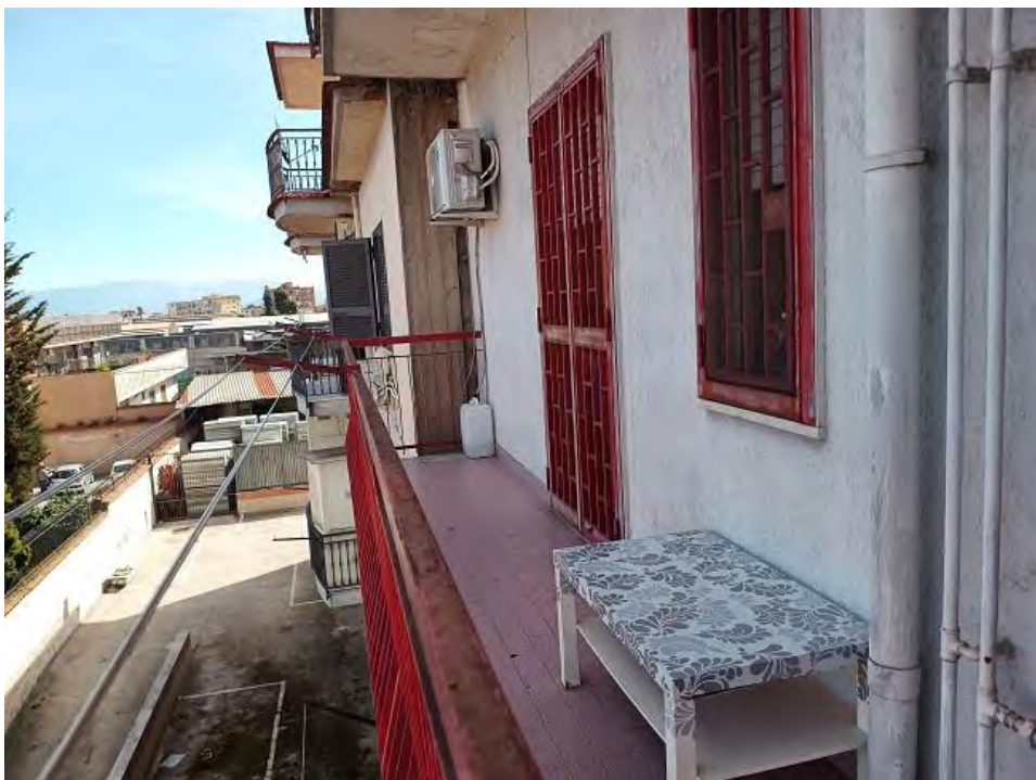
FOTO N. 24 – Balcone lato Nord
