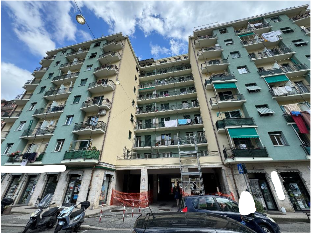
Figura 1 – Fabbricato più ampio
