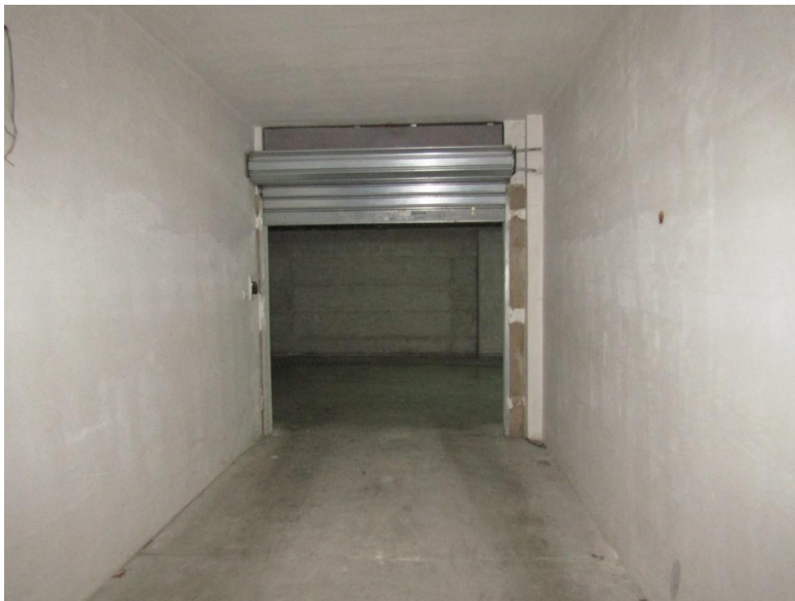
FOTO 23.7 - LOTTO 23 – BOX AUTO IN FOGGIA – PRIMO PIANO INTERRATO – INTERNO
