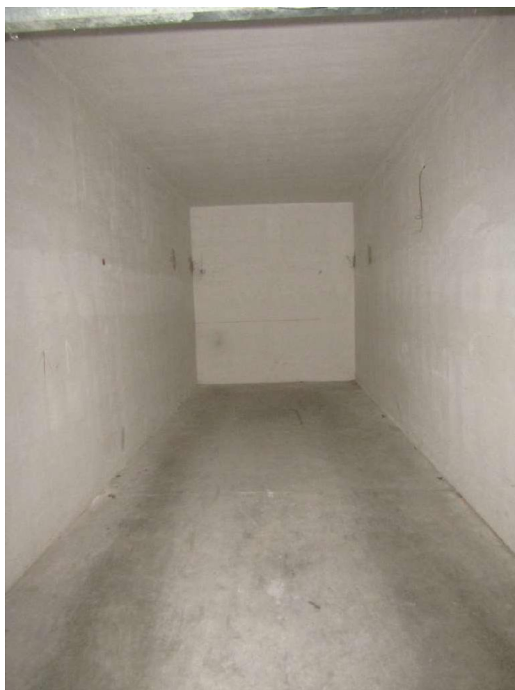
FOTO 23.6 - LOTTO 23 – BOX AUTO IN FOGGIA – PRIMO PIANO INTERRATO – INTERNO
