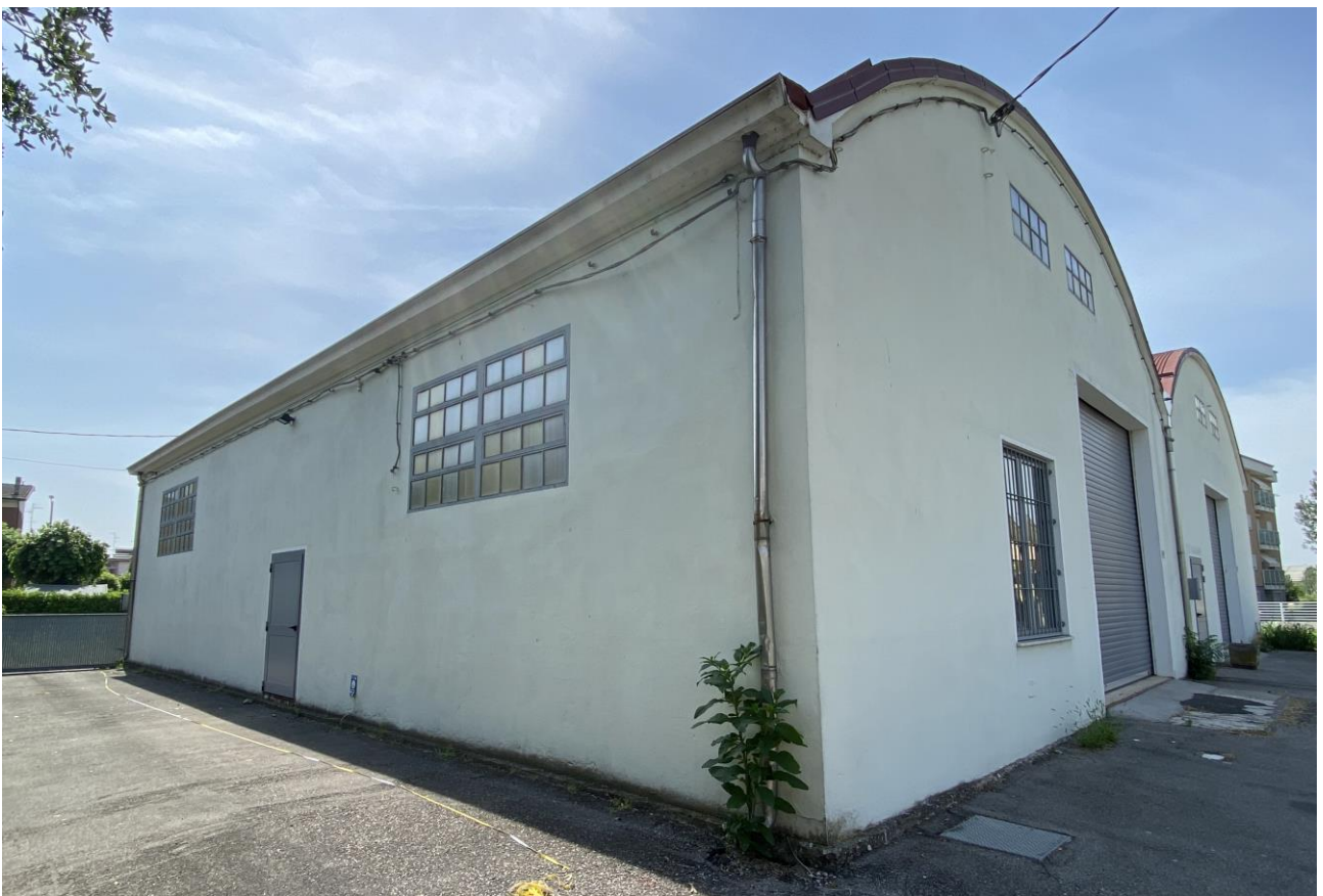
Fotografia 2 – Prospetti nord ed ovest
