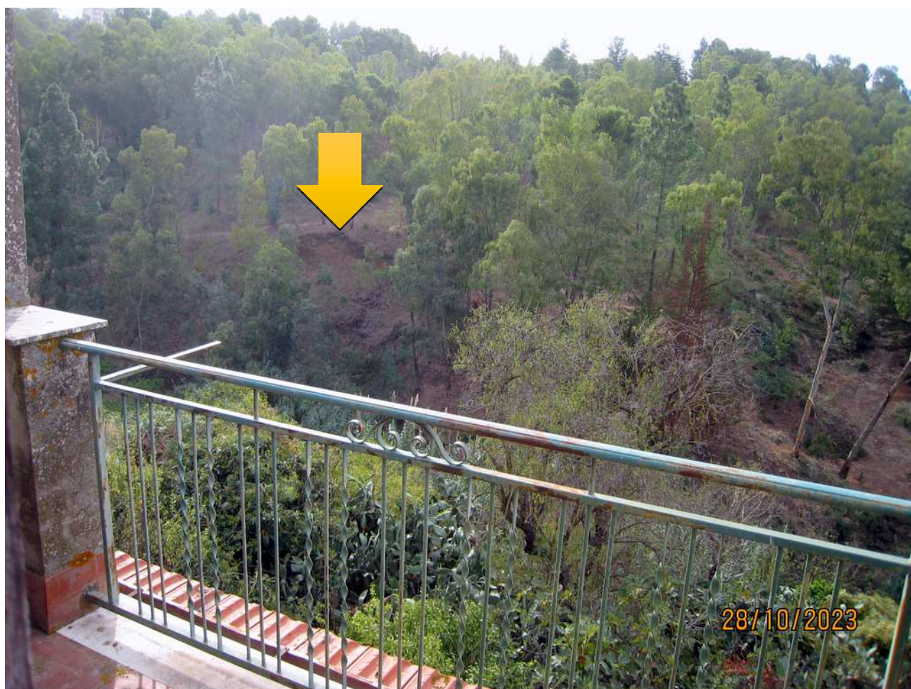
Foto n. 7. Il terreno di rimpetto al fabbricato, sull'argine opposto del torrente, è in frana.
