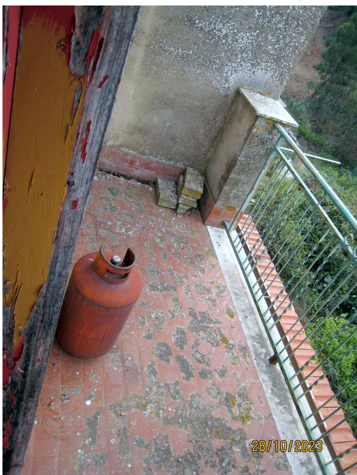
Foto n. 37. L'infisso di accesso al terrazzino è in cattive condizioni.
