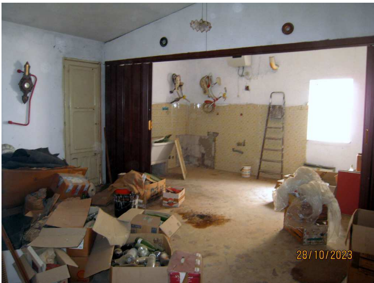
Foto n. 32. La stanza con il relativo terrazzo sopra la grande camera da letto del 1° piano. Essa è stata divisa in due parti da una lunga porta a soffietto. Si configura come una sorta di lavanderia.
