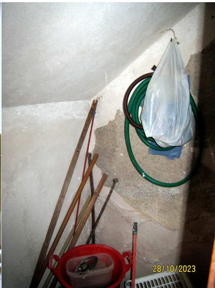
Foto n. 12. Il ripostiglio nel sotto scala del P.T.
