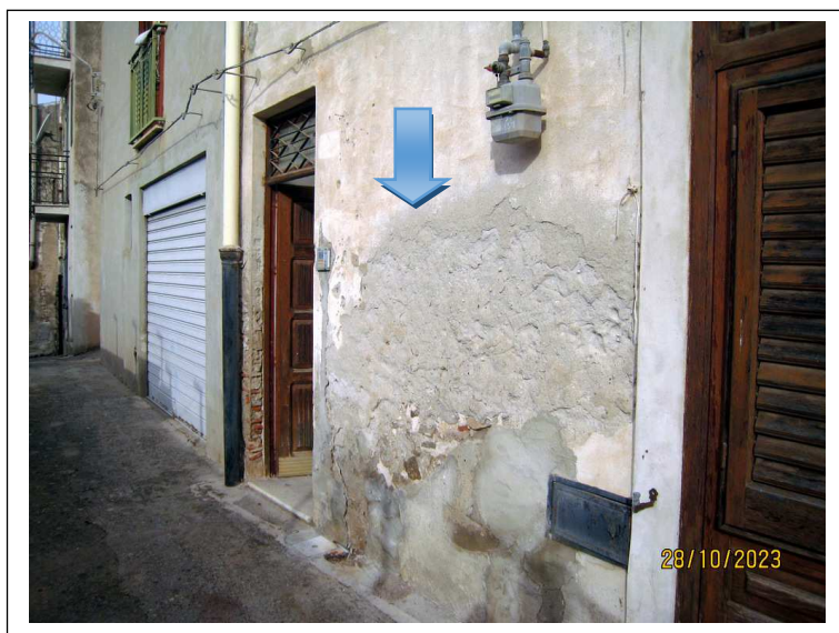
Foto n. 2-4. Il prospetto su Via Stesicoro con il dettaglio dell'umidità ascendente nella parte basamentale e del balcone crollato al secondo piano.
