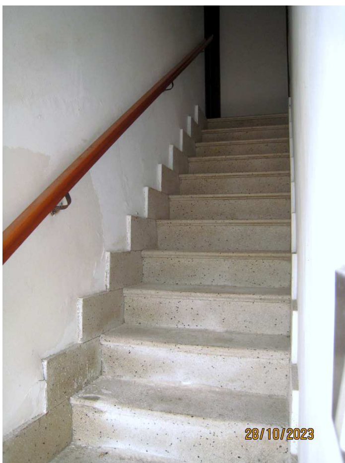
Foto n. 13. La rampa di scale che conduce al 1° piano.
