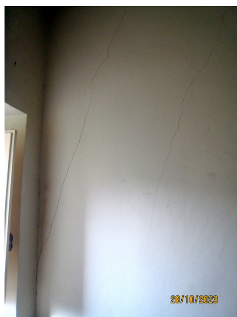
Foto n. 20-21. Sulle pareti di questa stanza si notano diverse lesioni.
