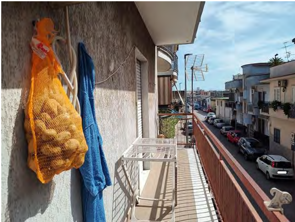
FOTO N. 12 – Balcone lato Sud
