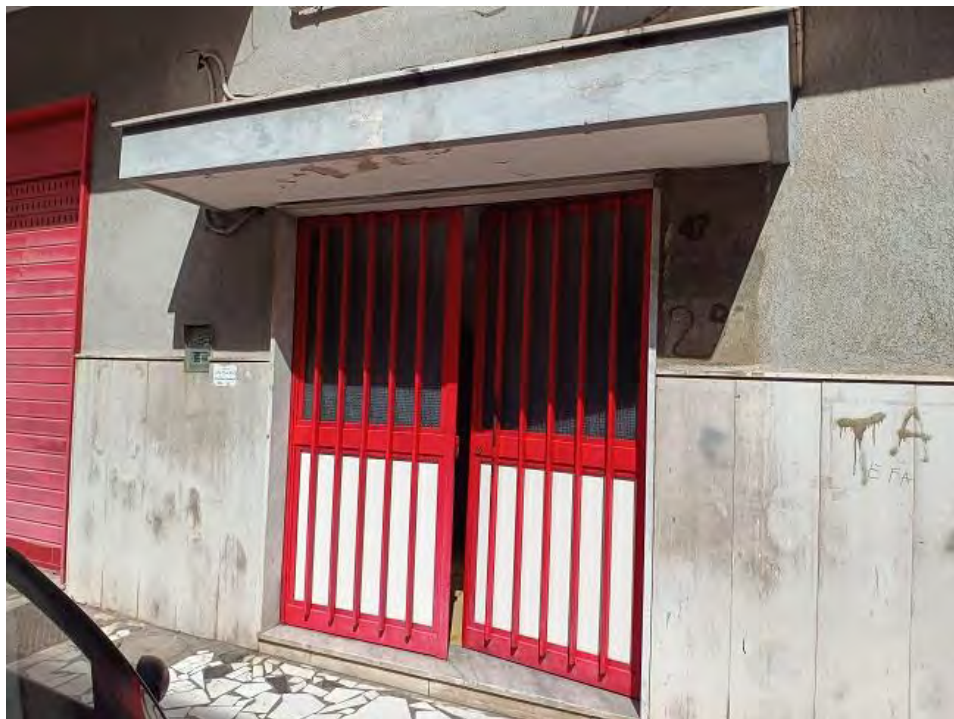
FOTO N. 3 – Porta di ingresso della cassa scala del fabbricato
