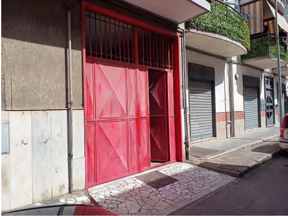
FOTO N. 13 – Portone carrabile per l'accesso al cortile del fabbricato
