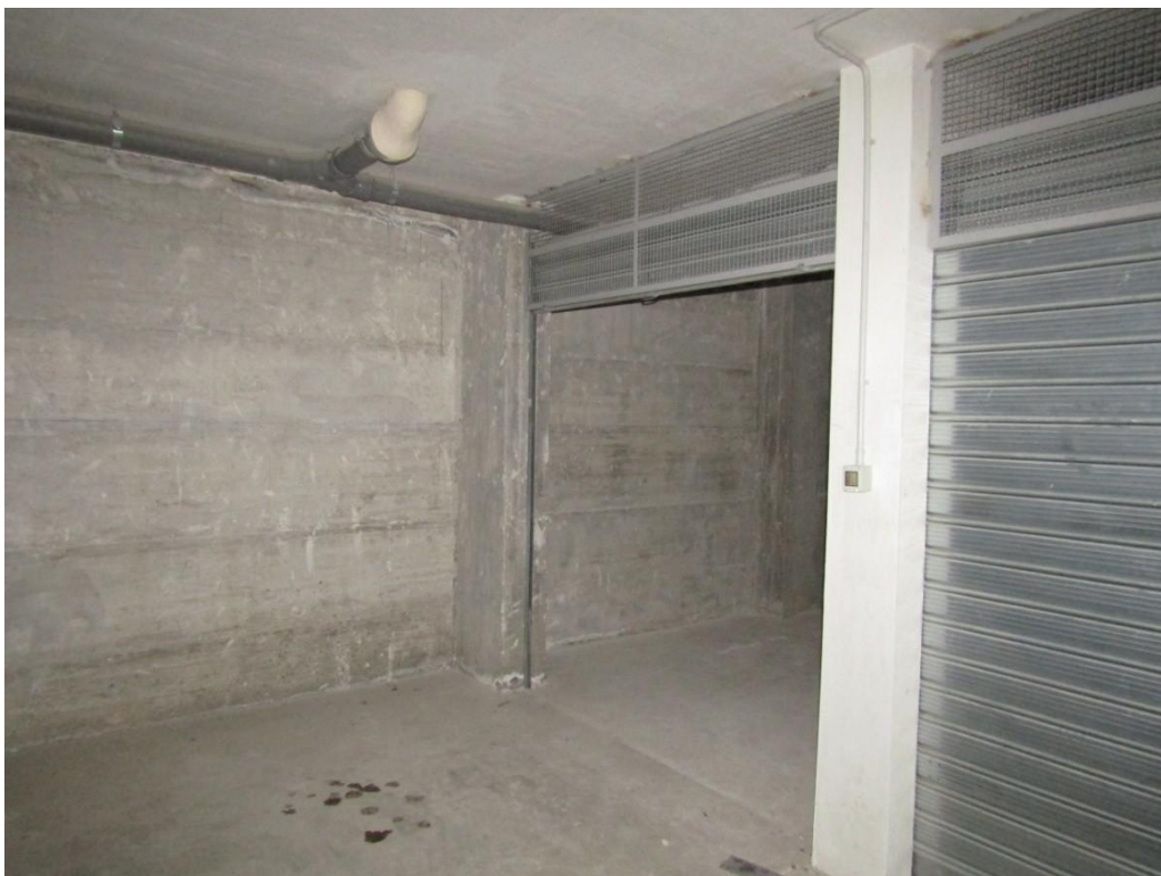
FOTO 18.5 - LOTTO 18 – BOX AUTO IN FOGGIA – PRIMO PIANO INTERRATO – CORSIA DI MANOVRA/INGRESSO
