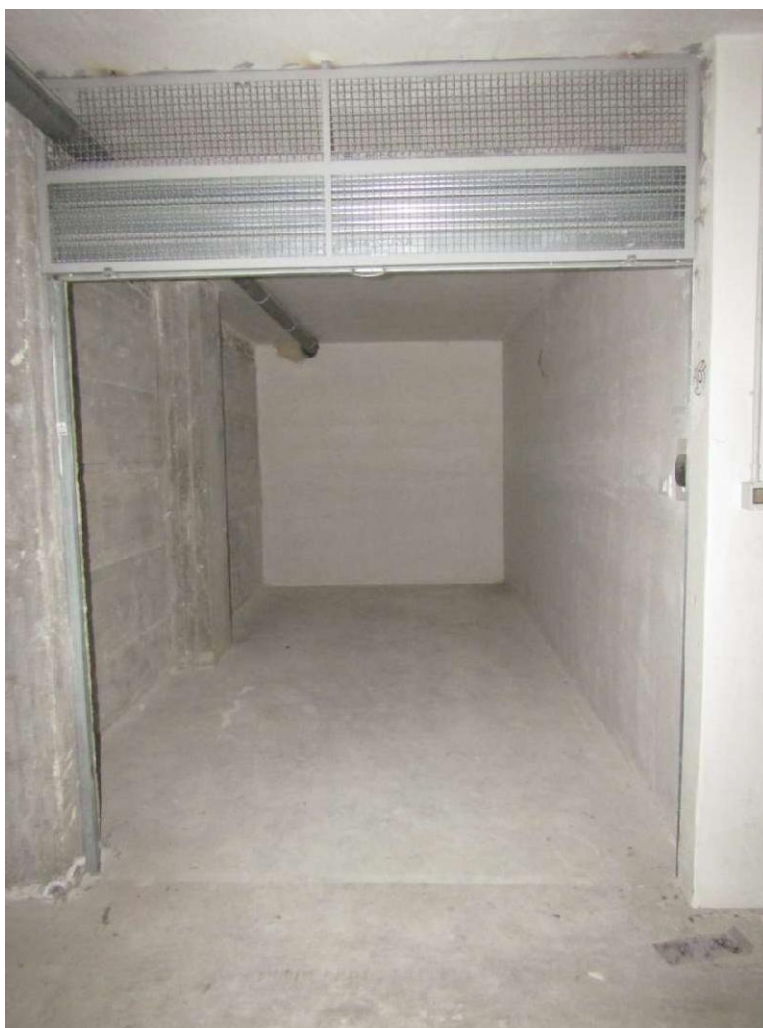
FOTO 18.6 - LOTTO 18 – BOX AUTO IN FOGGIA – PRIMO PIANO INTERRATO – IINGRESSO/INTERNO
