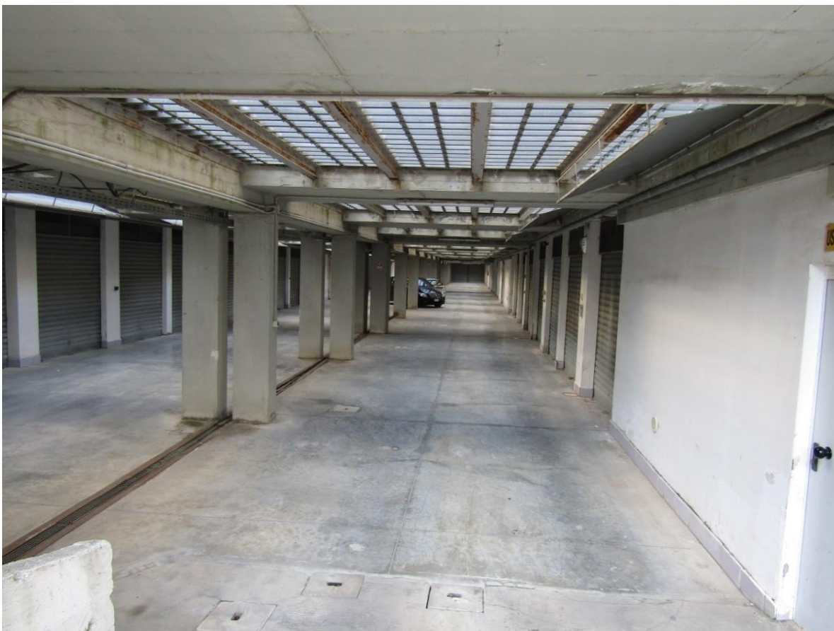
FOTO 17.3 - LOTTO 17 – BOX AUTO IN FOGGIA – PRIMO PIANO INTERRATO
