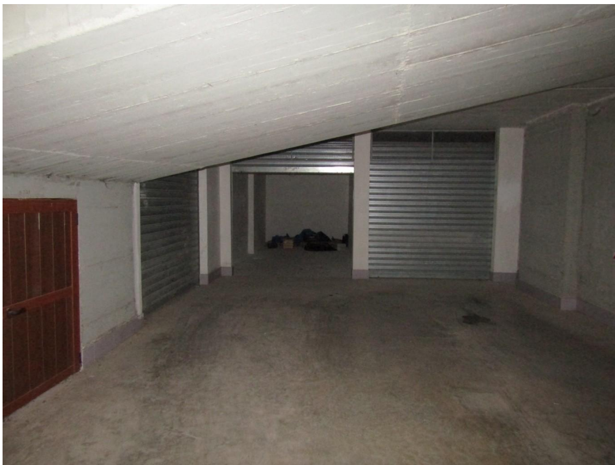
FOTO 16.4 - LOTTO 16 – BOX AUTO IN FOGGIA – PRIMO PIANO INTERRATO – CORSIA DI MANOVRA/INGRESSO
