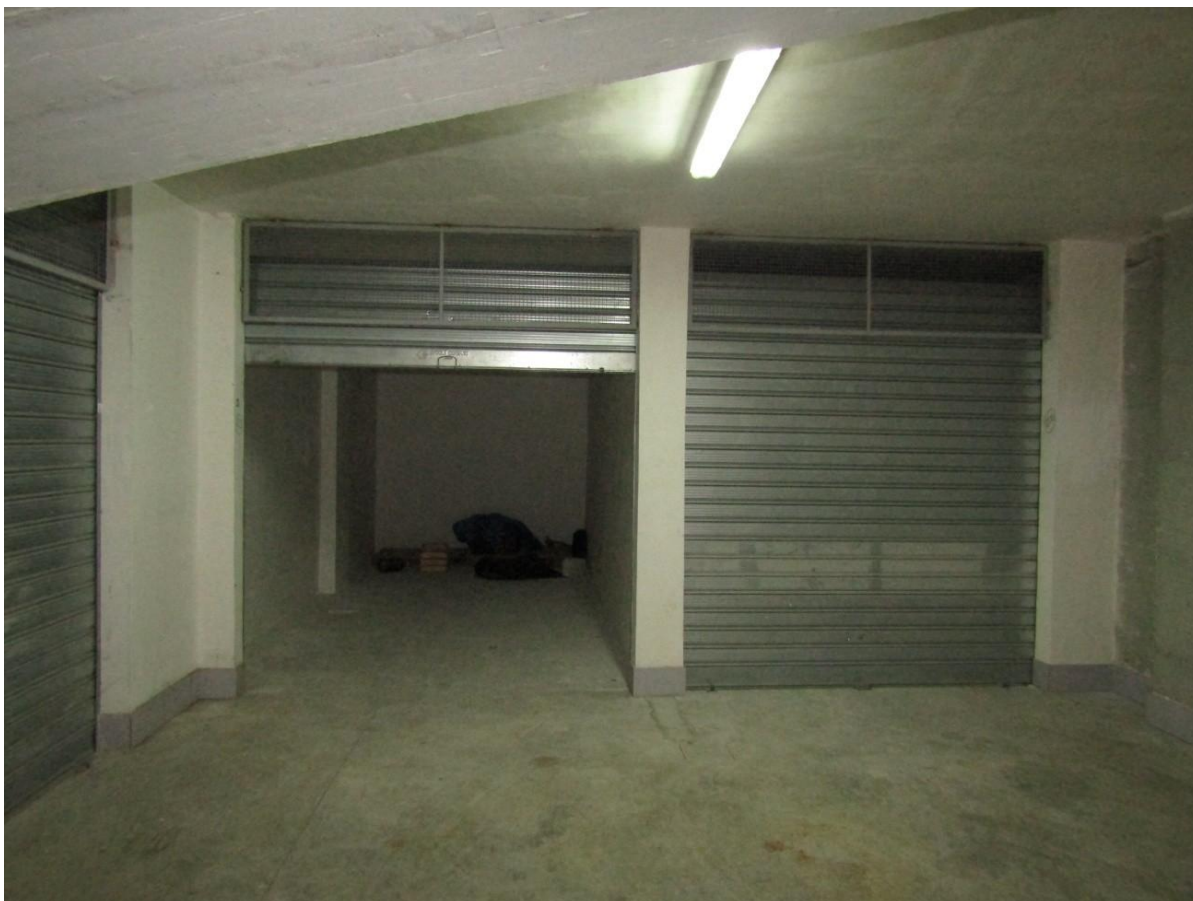
FOTO 16.5 - LOTTO 16 – BOX AUTO IN FOGGIA – PRIMO PIANO INTERRATO – INGRESSO
