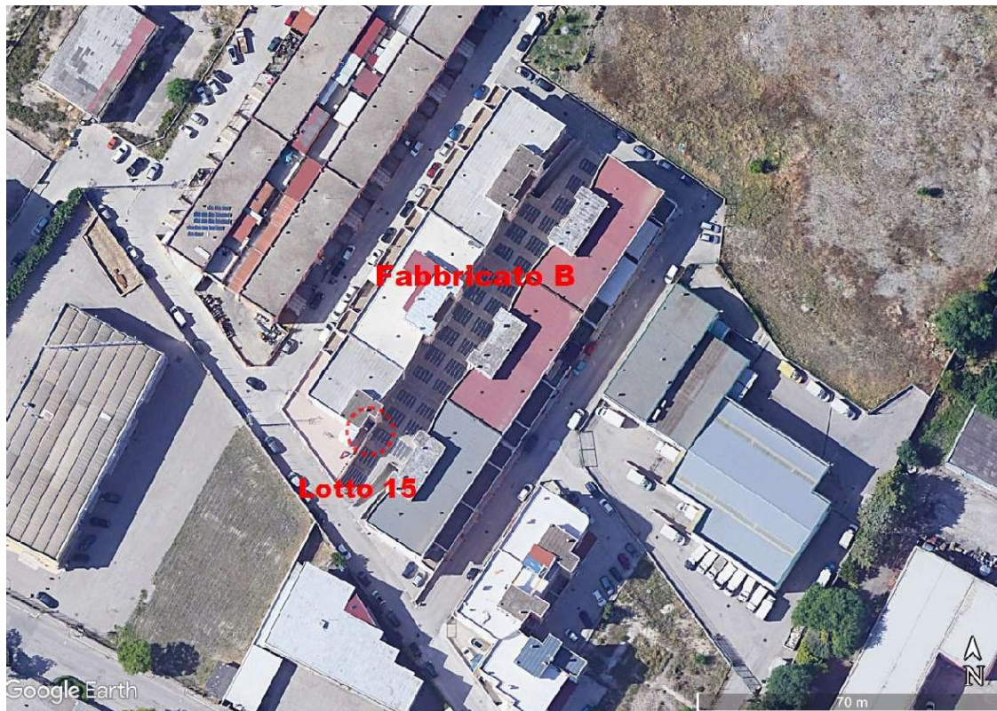
Fig. 1 – LOTTO 15 - Localizzazione dell'immobile all'interno del Fabbricato B sito in Foggia alla via Manfredonia angolo Via delle Casermette - Ortofoto
