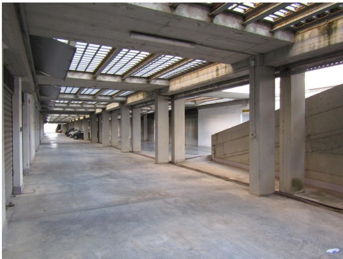
FOTO 15.3 - LOTTO 15 – BOX AUTO IN FOGGIA – PRIMO PIANO INTERRATO - CORSIA DI MANOVRA
