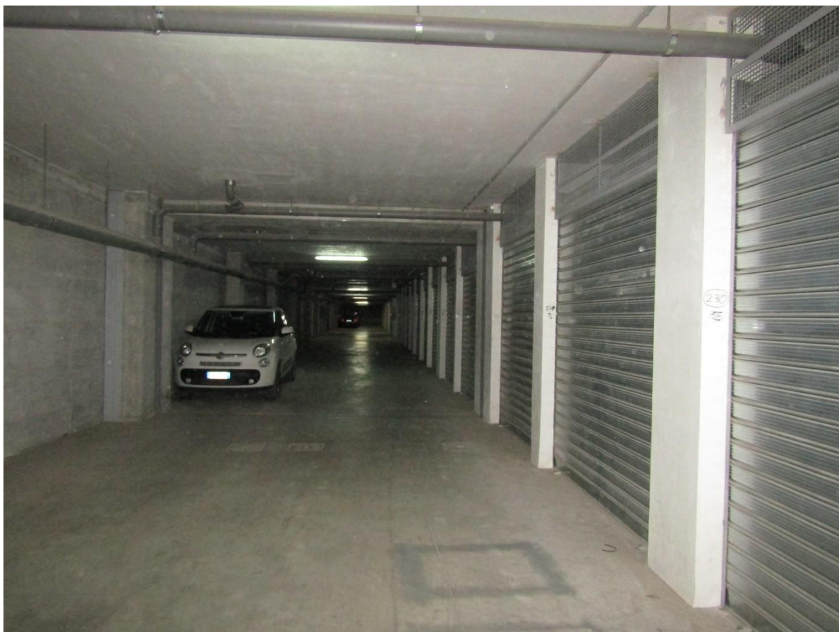
FOTO 29.4 - LOTTO 29 – BOX AUTO IN FOGGIA – PRIMO PIANO INTERRATO – CORSIA DI MANOVRA
