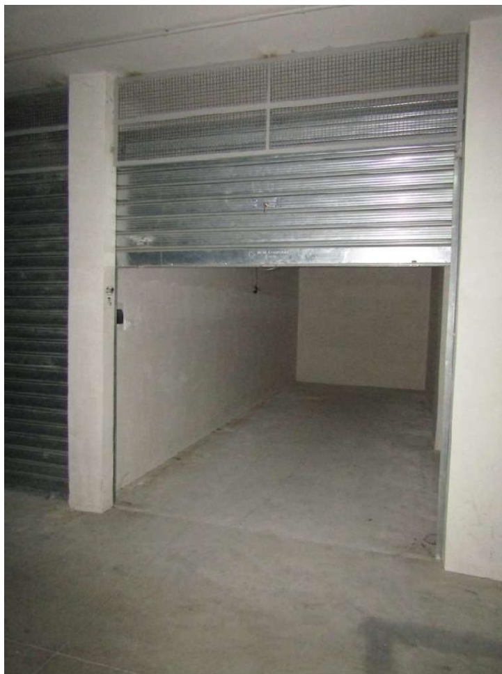
FOTO 29.5 - LOTTO 29 – BOX AUTO IN FOGGIA – PRIMO PIANO INTERRATO – INGRESSO
