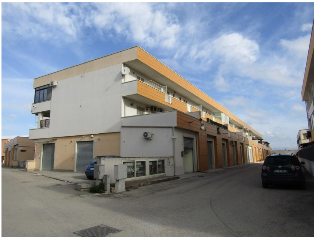
FOTO 13.1 - LOTTO 13 – LOCALE DEPOSITO IN FOGGIA – FABBRICATO B
