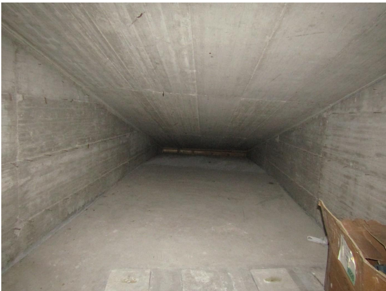
FOTO 13.7 - LOTTO 13 – LOCALE DEPOSITO IN FOGGIA – PRIMA PIANO INTERRATO – INTERNO
