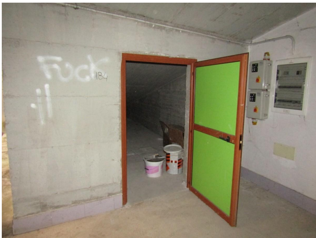
FOTO 13.6 - LOTTO 13 – LOCALE DEPOSITO IN FOGGIA – PRIMA PIANO INTERRATO – INGRESSO
