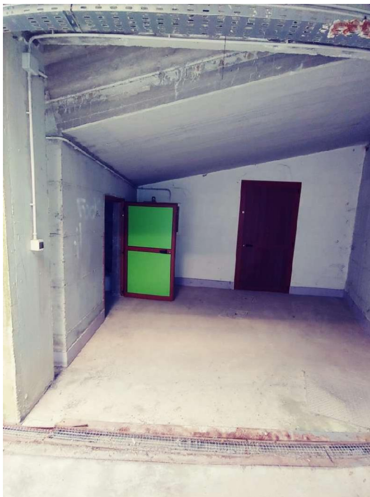
FOTO 13.5 - LOTTO 13 – LOCALE DEPOSITO IN FOGGIA – PRIMA PIANO INTERRATO – INGRESSO
