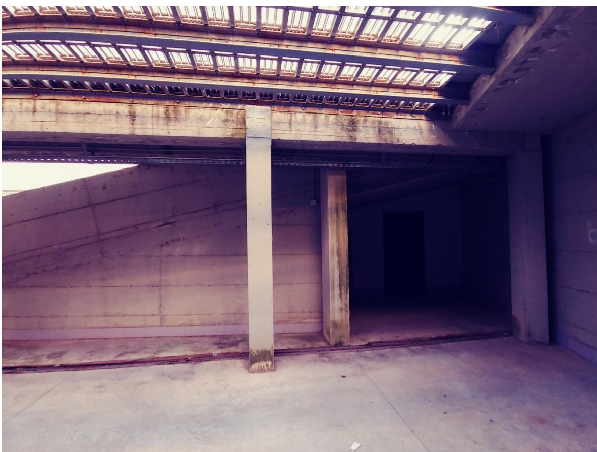
FOTO 13.4 - LOTTO 13 – LOCALE DEPOSITO IN FOGGIA – PRIMA PIANO INTERRATO – CORSIA DI MANOVRA
