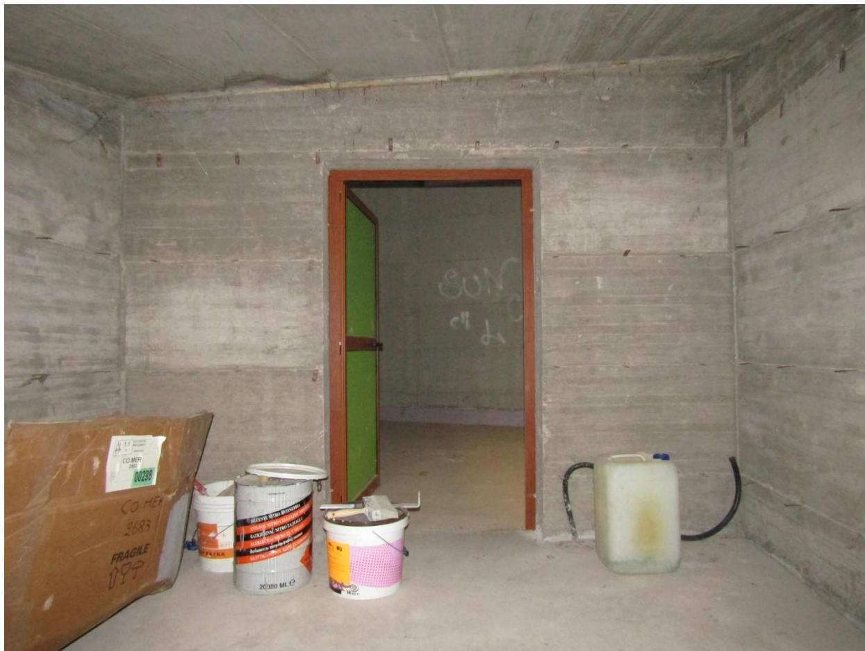
FOTO 13.8 - LOTTO 13 – LOCALE DEPOSITO IN FOGGIA – PRIMA PIANO INTERRATO – INTERNO
